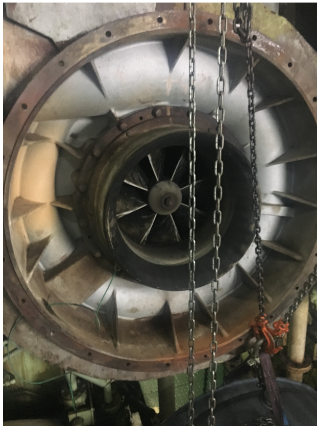
Ilustración nº 52: Desmontaje turbocompresor Fuente: [10] [Trabajo de campo]
