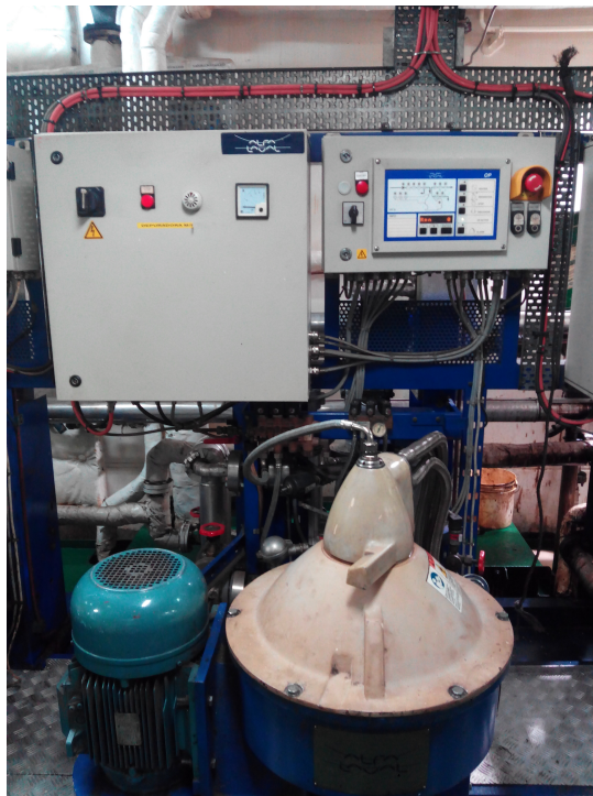
Ilustración nº 35: Depuradora de aceite MMPP Fuente: [10] [Trabajo de campo]
