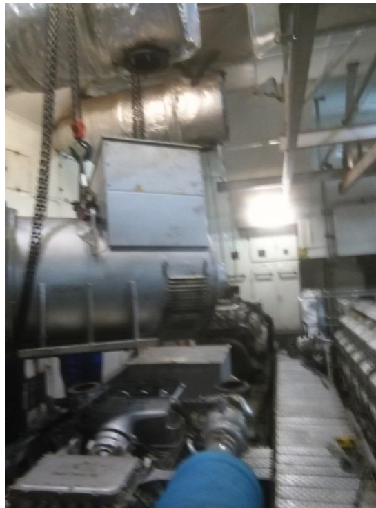
Imagen nº 136. Movimiento del alternador.
