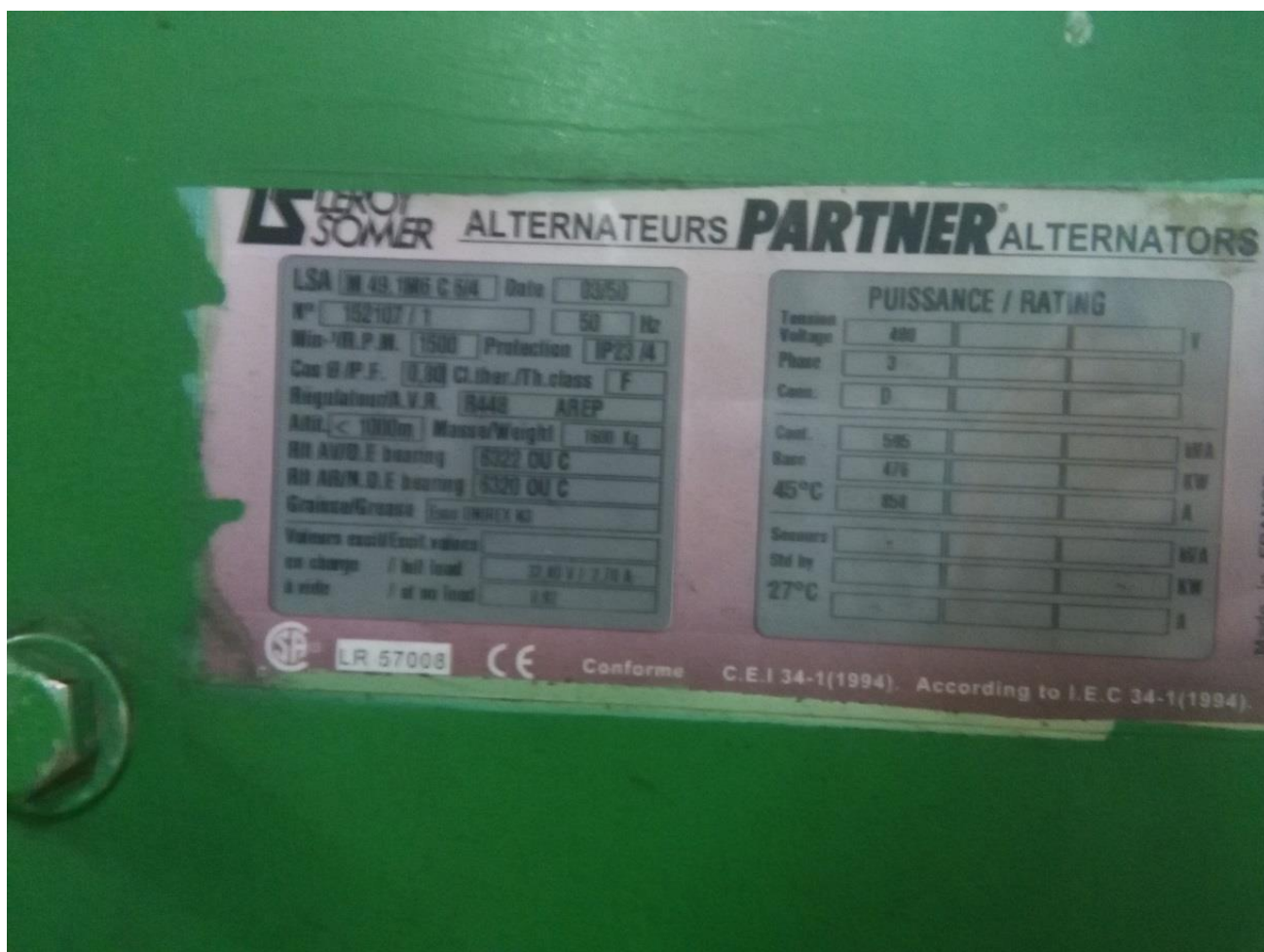
Imagen nº 40. Placa característica de un alternador.
