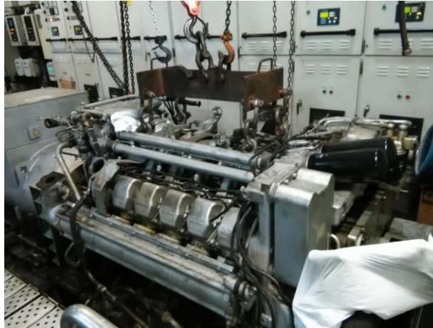
Imagen nº 133. Montaje de maniobra y útil de elevación sobre el generador.
