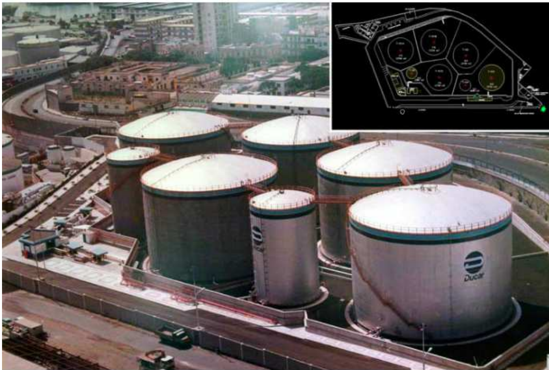
Foto aérea de los tanques de almacenamiento en el Puerto de Las Palmas. Fuente: www.petrologiscanarias.com
