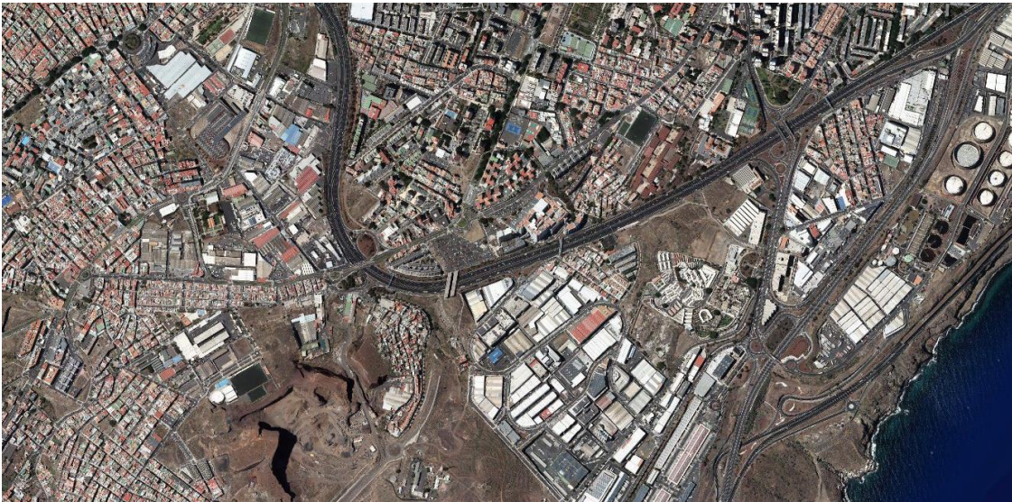
Ilustración 2: Emplazamiento de la instalación. [31]
