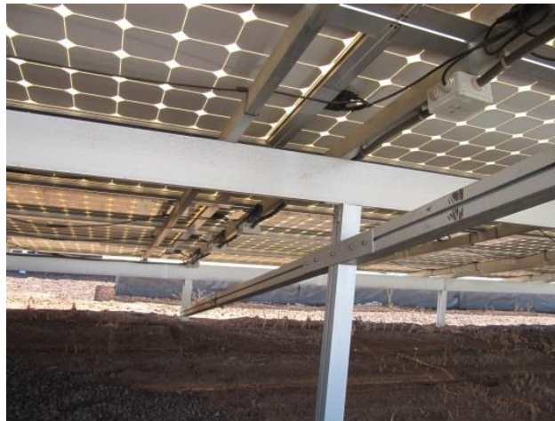
Ilustración 32: Ejemplo de distribución del cableado.
