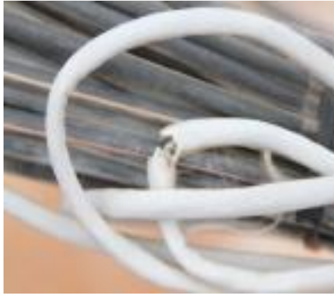
Ilustración 37: Ejemplo de rotura del aislamiento de un cable. [26]
