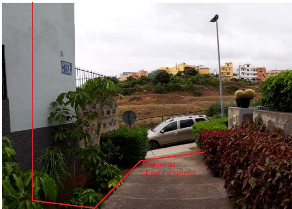
Imagen 11: Cableado módulos del bloque 1 para conectar en módulo 2.
