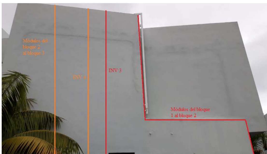
Imagen 13: Cableado inversores 3 y 4 hasta punto de conexión.
