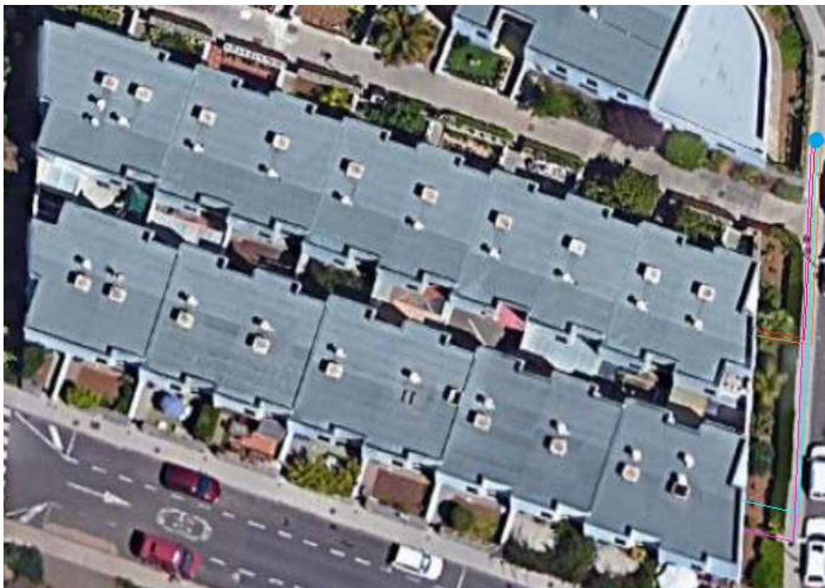
Imagen 15: Cableado inversores de los bloques 2 y 3 hasta punto de conexión.
