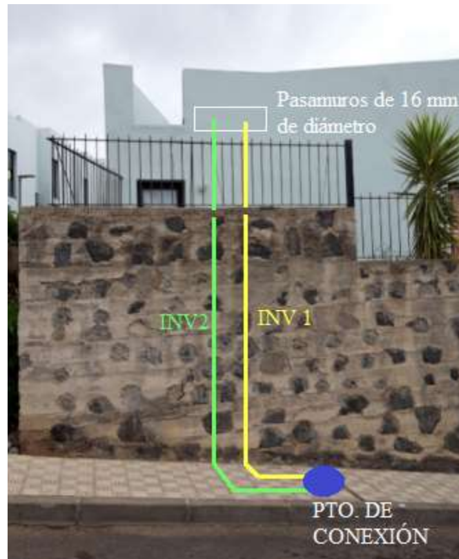
Imagen 10: Cableado inversores 1 y 2 hasta punto de conexión.
