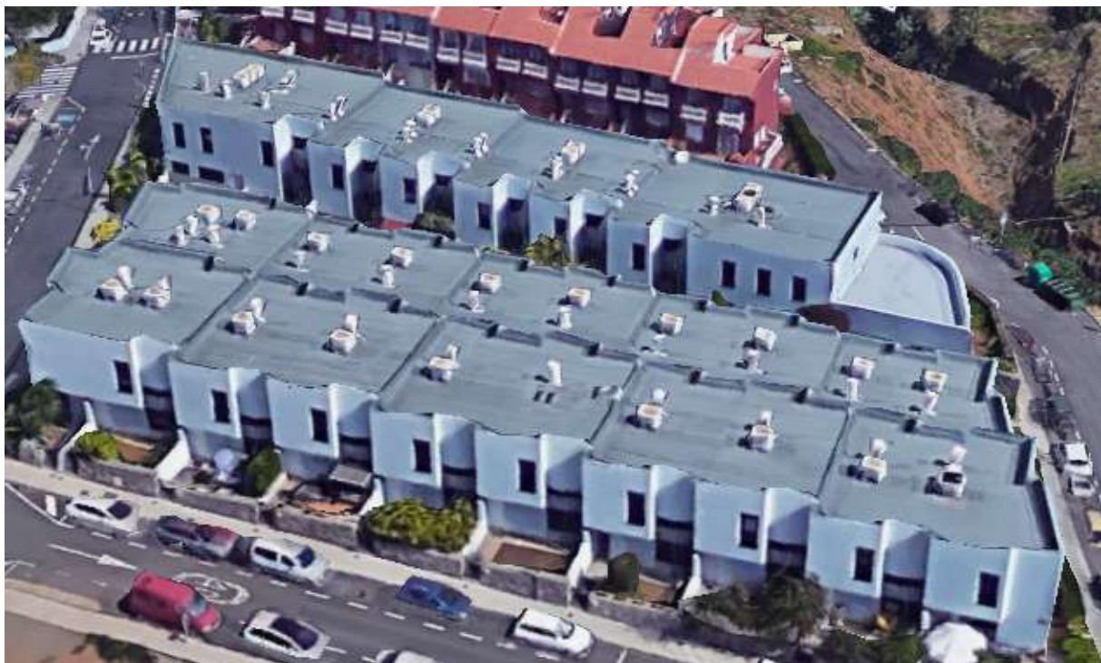
Imagen 2: Vista cercana de los edificios.
