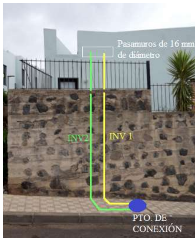
Imagen 9: Cableado inversores 1 y 2 hasta punto de conexión.
