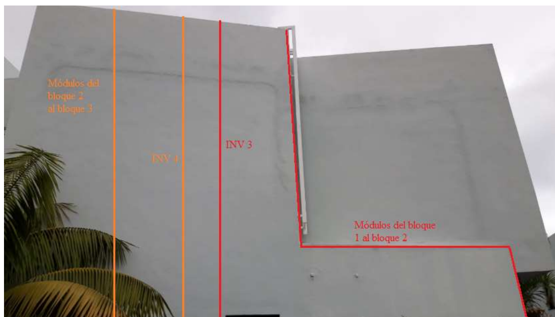
Imagen 12: Cableado inversores 3 y 4 hasta punto de conexión.
