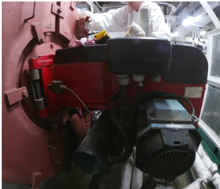
Figura 1.14: Mantenimiento en la zona del quemador
