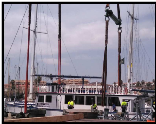
Ilustración n° 163. Soltando eslingas de popa.
