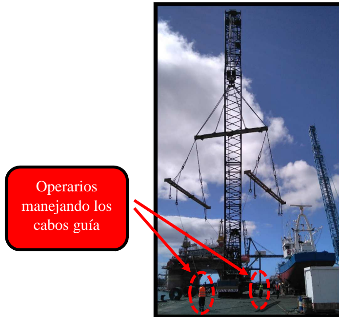
Ilustración n° 126. Izando los separadores. Fuente: Trabajo de campo.
