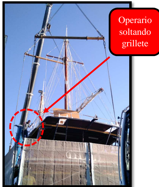
Ilustración n° 118. Quitando grilletes para soltar eslingas. Fuente: Trabajo de campo.
