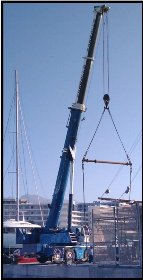
Ilustración n° 110. Grúa telescópica a proa “Liebherr LTM 1250-6.1”. Fuente: Trabajo de campo.
