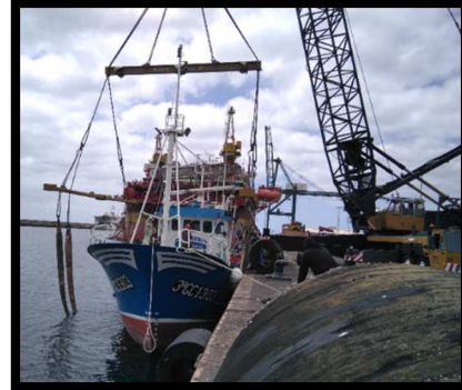
Ilustración n° 100. Buque listo para comenzar el izado. Fuente: Trabajo de campo.
