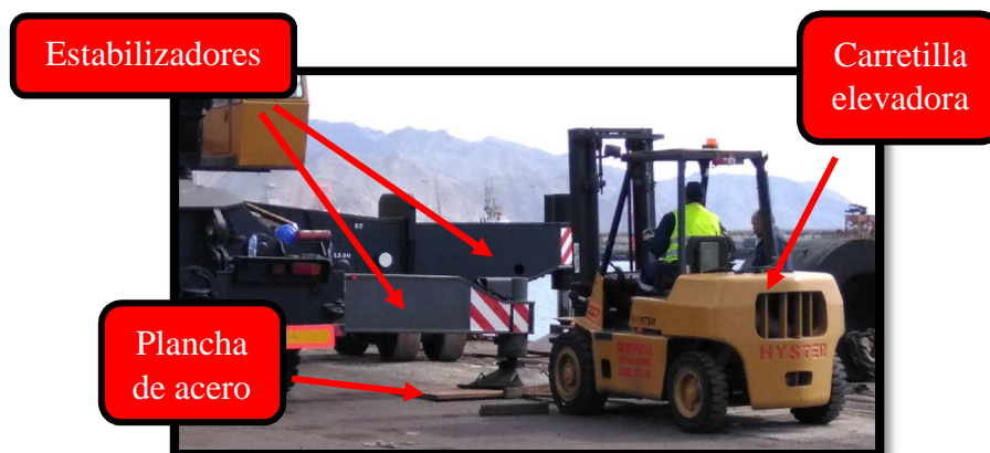
Ilustración nº 71. Colocación de planchas de acero debajo de los estabilizadores. Fuente: Trabajo de campo.
