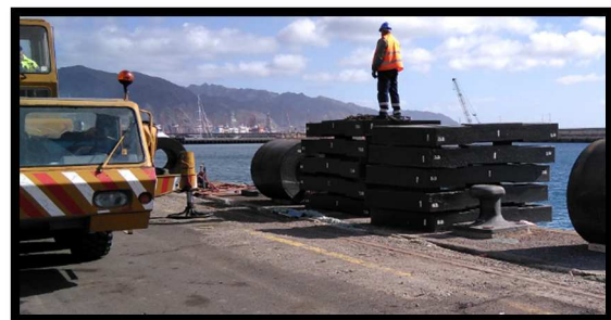
Ilustración n° 123. Contrapesos dispuestos sobre el muelle. Fuente: Trabajo de campo.
