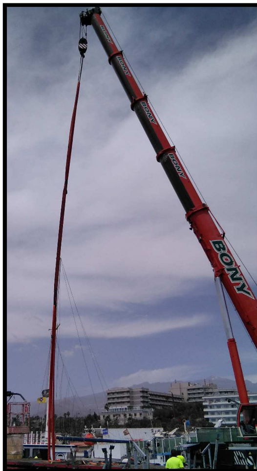
Ilustración nº 165. Retirando resto de los aparejos de izado. Fuente: Trabajo de campo.
