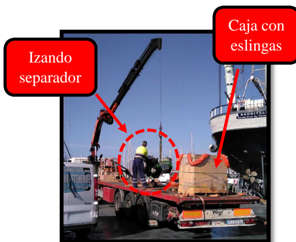
Ilustración n° 153. Camión grúa. Fuente: Trabajo de campo.
