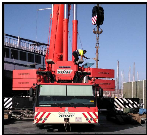
Ilustración n° 147. Operario guiando contrapeso. Fuente: Trabajo de campo.
