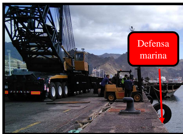
Ilustración n° 72. Retirando defensa marina del muelle.
