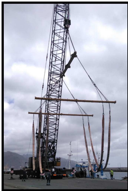
Ilustración n° 97. Izando aparejos. Fuente: Trabajo de campo.
