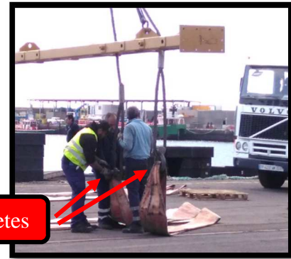
Ilustración n° 75. Uniendo eslingas a los estrobos de izado.
