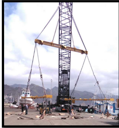
Ilustración n° 96. Preparando aparejos de izado. Fuente: Trabajo de campo.
