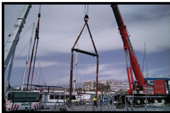
Ilustración n° 164. Retirando separador de popa.
