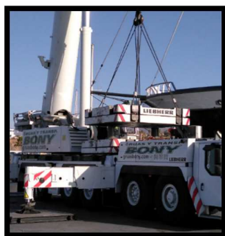
Ilustración n° 151. Grúa LTM 1250, colocando contrapesos centrales. Fuente: Trabajo de campo.
