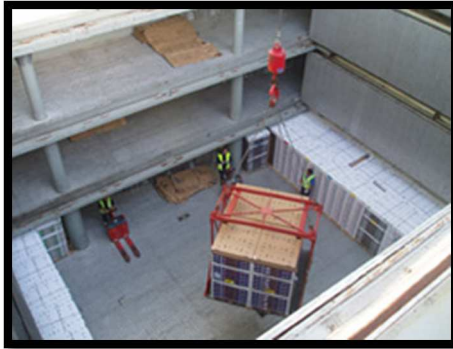
Ilustración n° 65. Maniobra de estiba con jaula y grúa. Fuente: [59].
