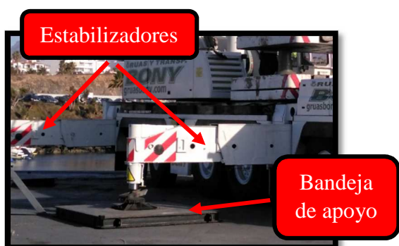
Ilustración n° 142. Grúa LTM 1250 con estabilizador calzado. Fuente: Trabajo de campo.
