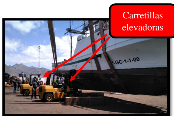
Ilustración n° 84. Colocando los maderos de varada empleando carretillas elevadoras.
