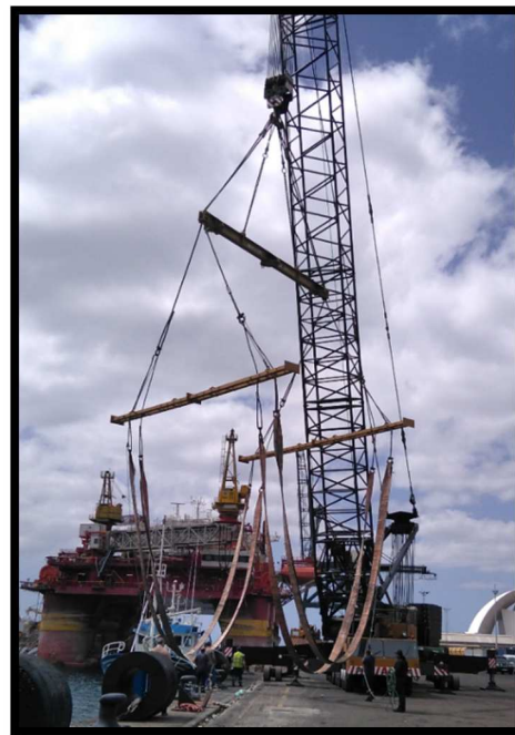
Ilustración n° 98. Girando aparejos de izado. Fuente: Trabajo de campo.
