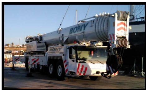
Ilustración nº 140. Grúa “Liebherr LTM 1250-5.1” situada a proa-babor del buque. Fuente: Trabajo de campo.
