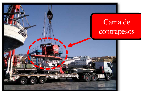
Ilustración n° 144. Grúa LTM 1400 izando cama de contrapesos. Fuente: Trabajo de campo.
