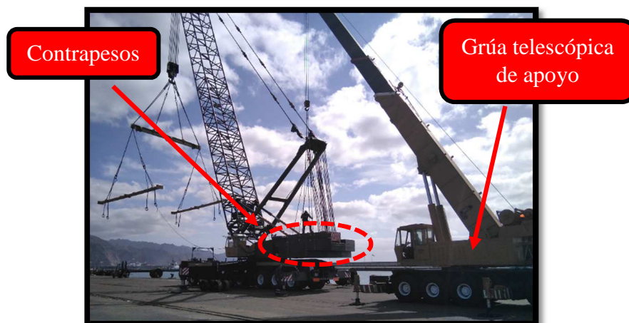
Ilustración n° 95. Colocando contrapesos en grúa de celosía. Fuente: Trabajo de campo.
