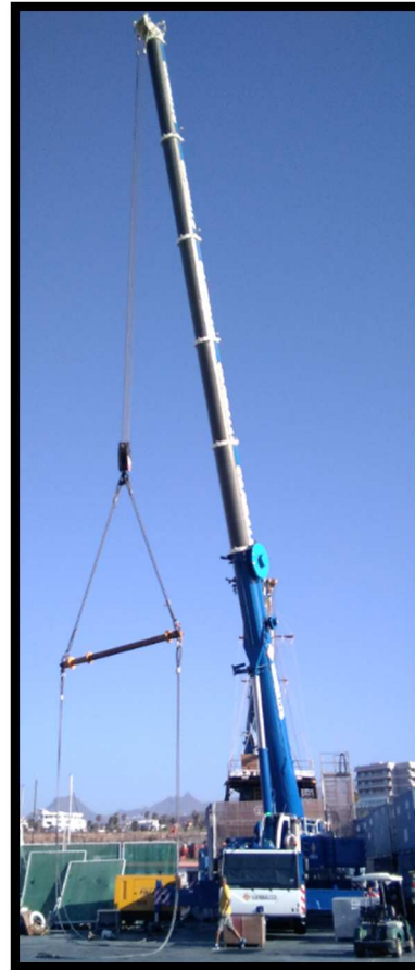
Ilustración n° 111. Grúa telescópica a popa “Liebherr LTM 1200-5.1”. Fuente: Trabajo de campo.
