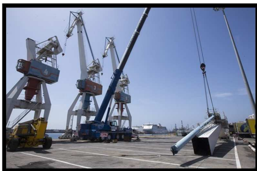
Ilustración nº 6. Desguace de las antiguas grúas eléctricas de pórtico 6T-2, 6T-3 y 6T-4 (2015). Fuente: [6].
