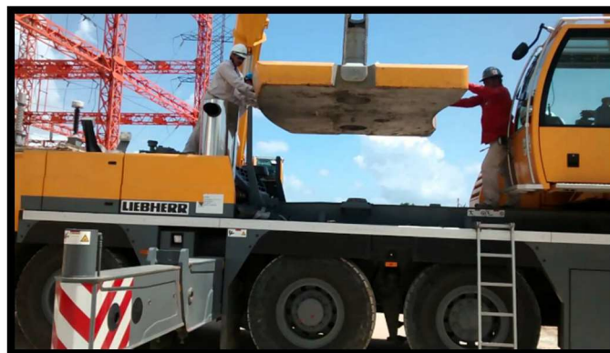
Ilustración nº 35. Colocación de contrapesos en una grúa móvil autopropulsada. Fuente: [39].
