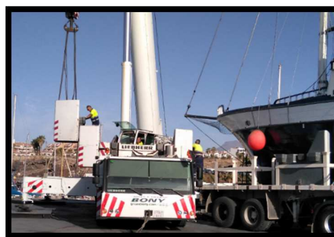
Ilustración n° 152. Grúa LTM 1250, colocando contrapesos laterales. Fuente: Trabajo de campo.
