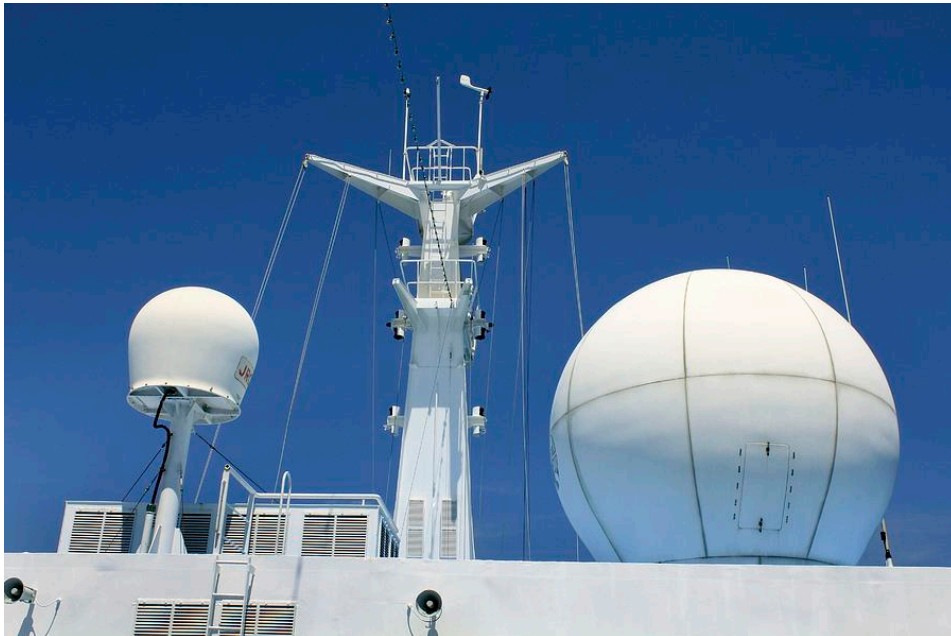
Ilustración 13. Antena radar radome. Fuente [12]
