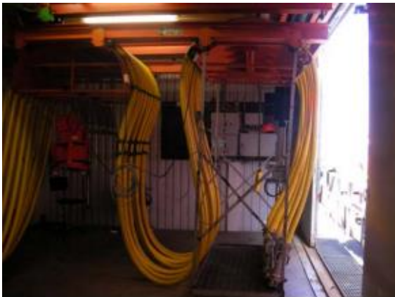
Ilustración 24:Plataforma portacables.
