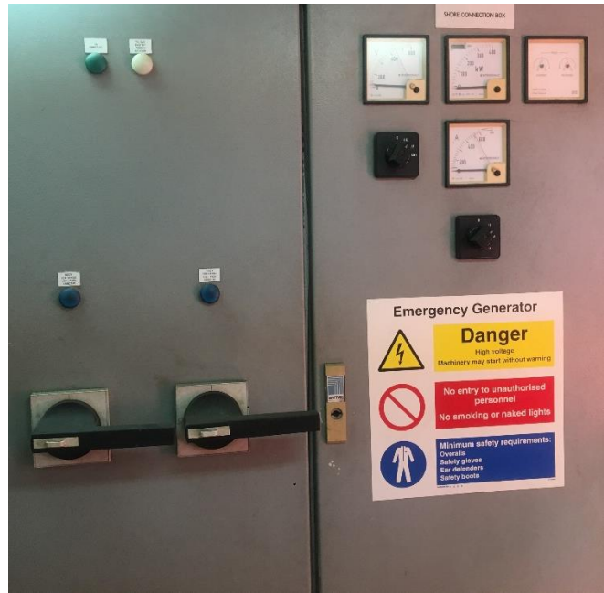
Ilustración 40: Armario de conexión a tierra en la actualidad. Fuente: Trabajo de campo
