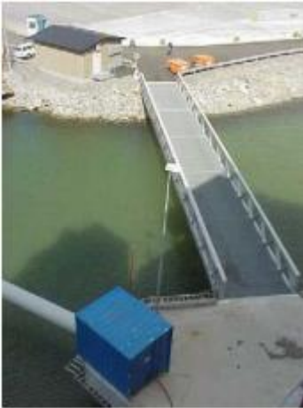
Ilustración 22: Casetas de conexión. Fuente: (24)
