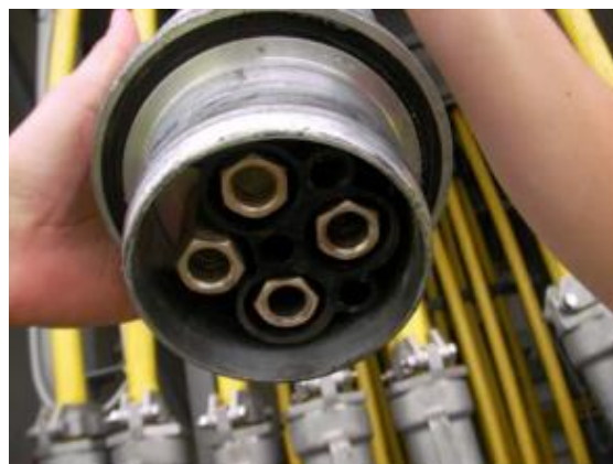
Ilustración 26: Conector de 400 V. Fuente: (24)
