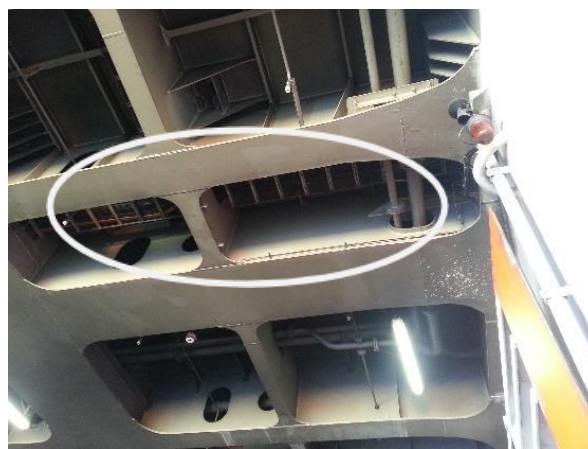
Ilustración 48: Techo de la bodega y bandeja.
