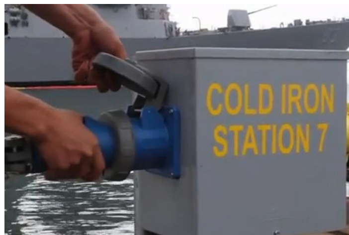
Ilustración 15: Conector cold ironing militar de baja tensión. Fuente: (1)
