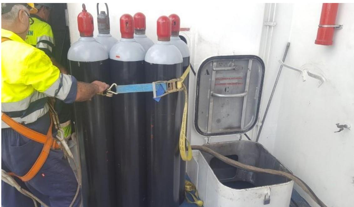
**Ilustración 59: Sustitución botellas CO2 salas de máquinas. Fuente: Elaboración propia.**
