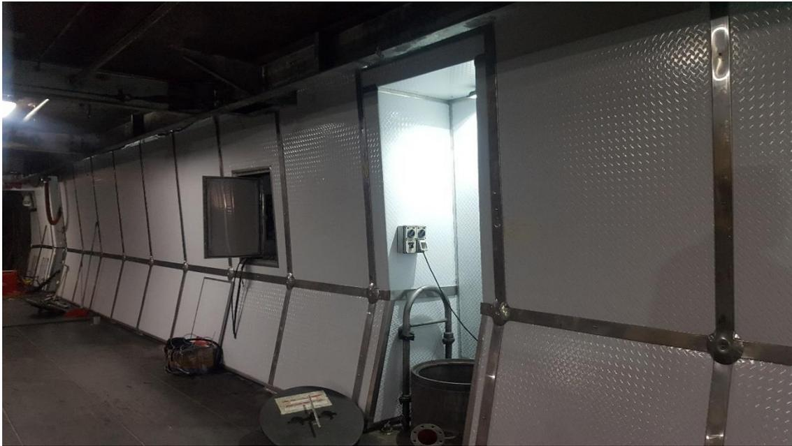
**Ilustración 31: Costado de estribor con las lamas A-60. Fuente: Elaboración propia.**
