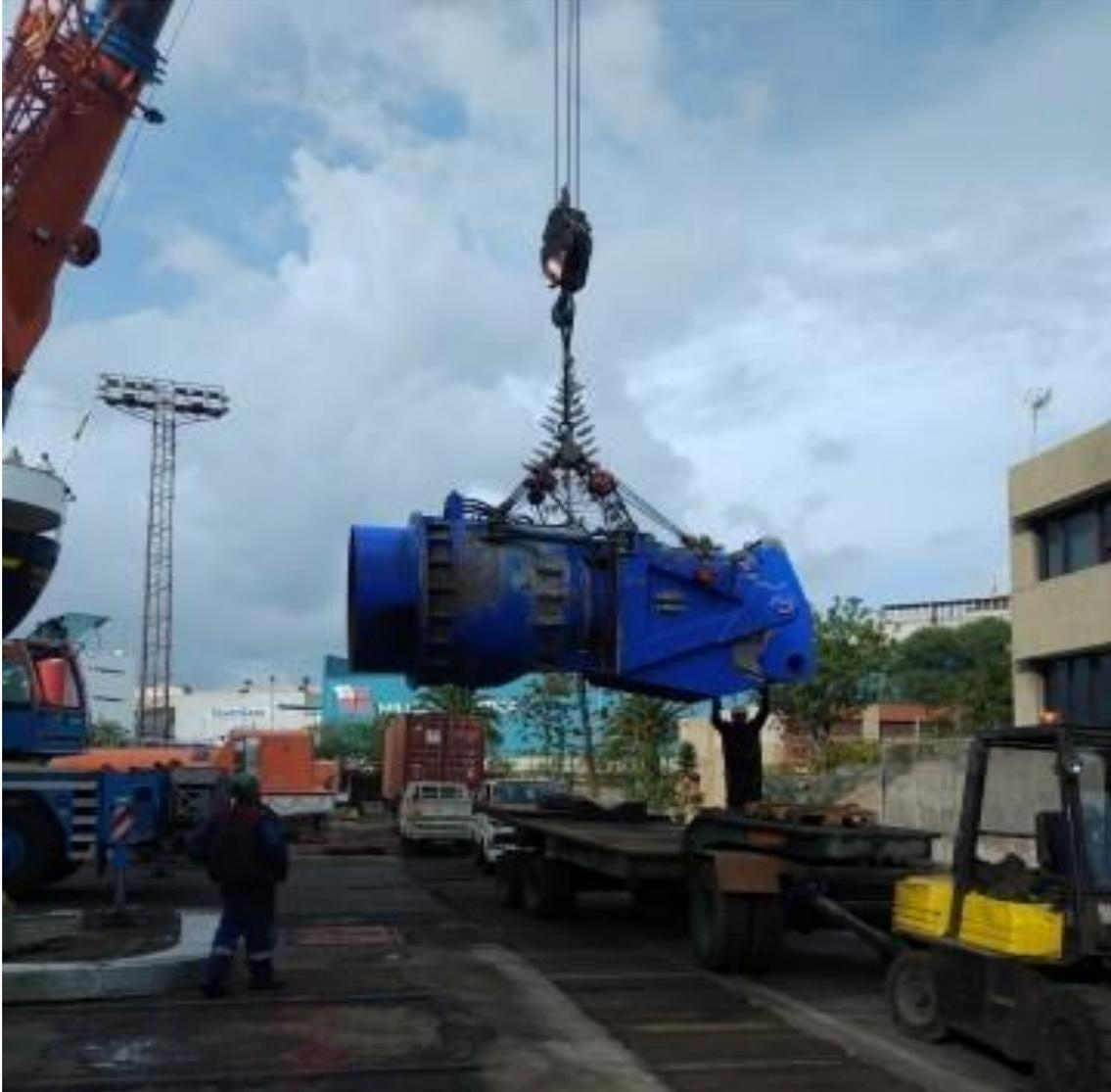
**Ilustración 48: Operación izada waterjet. Fuente: Elaboración propia.**
