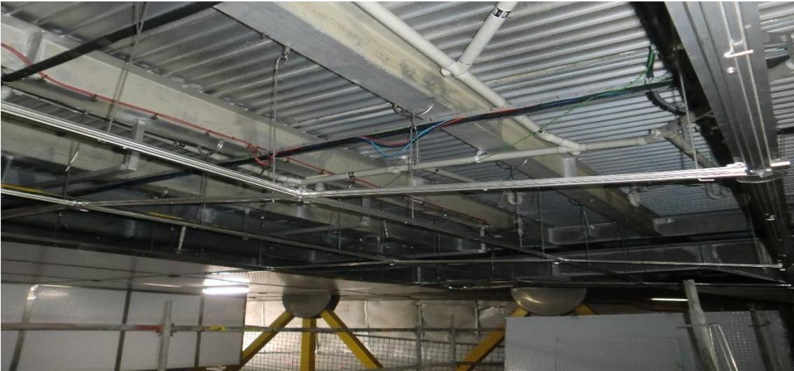
**Ilustración 37: Instalación rastrelado en el techo. Fuente: Elaboración propia.**
