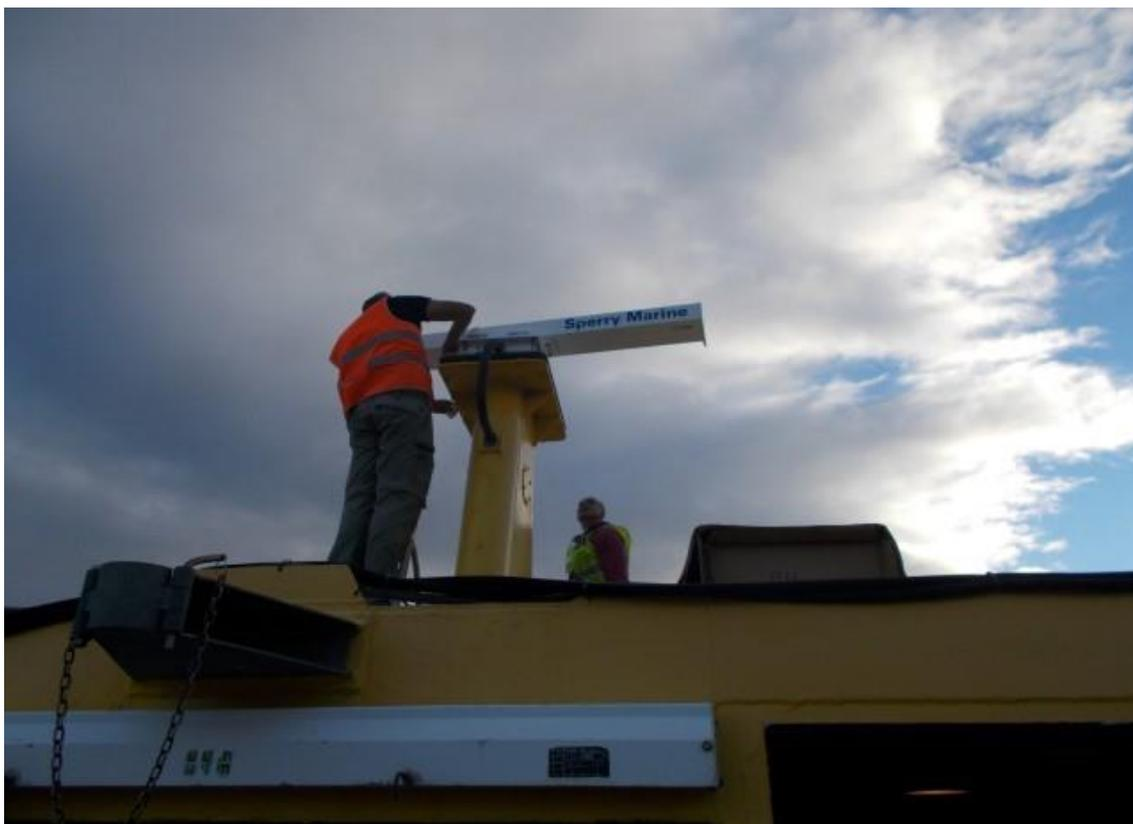
Ilustración 51: Instalación antena radar banda X. Fuente: Elaboración propia.
