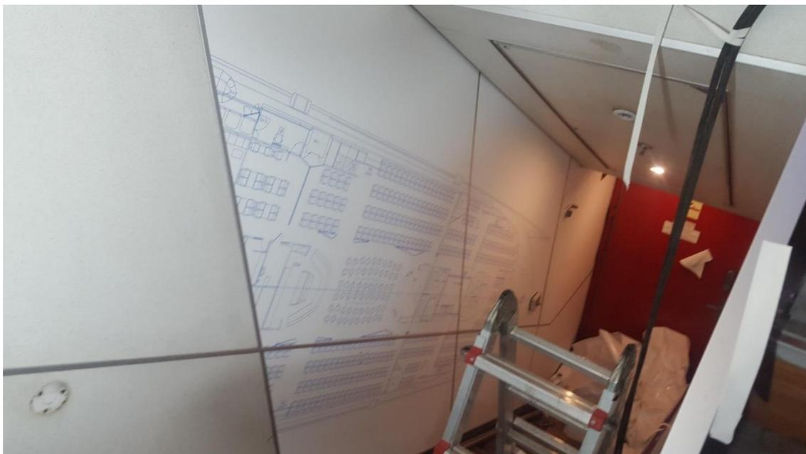
**Ilustración 61: Colocación vinilos acceso garaje. Fuente: Elaboración propia.**
