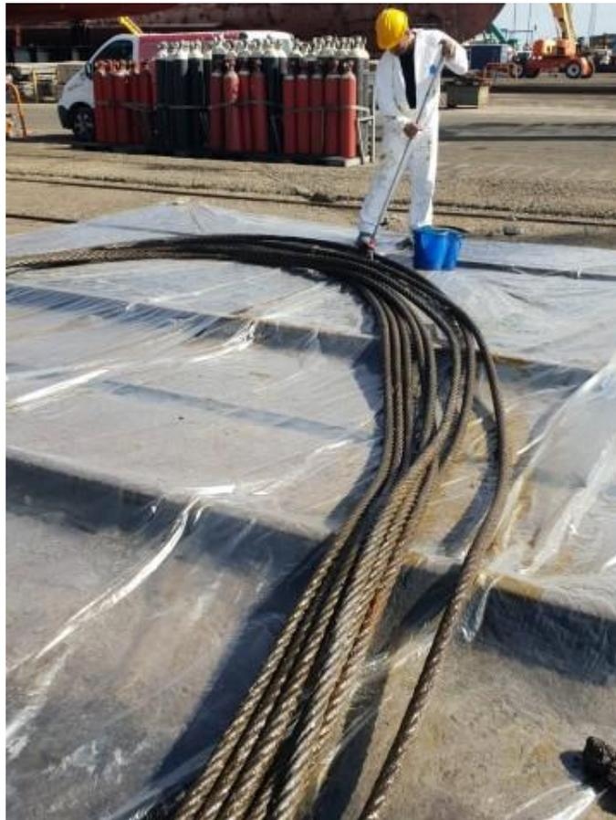
**Ilustración 55: Limpieza cable con gasoil. Fuente: Elaboración propia.**
