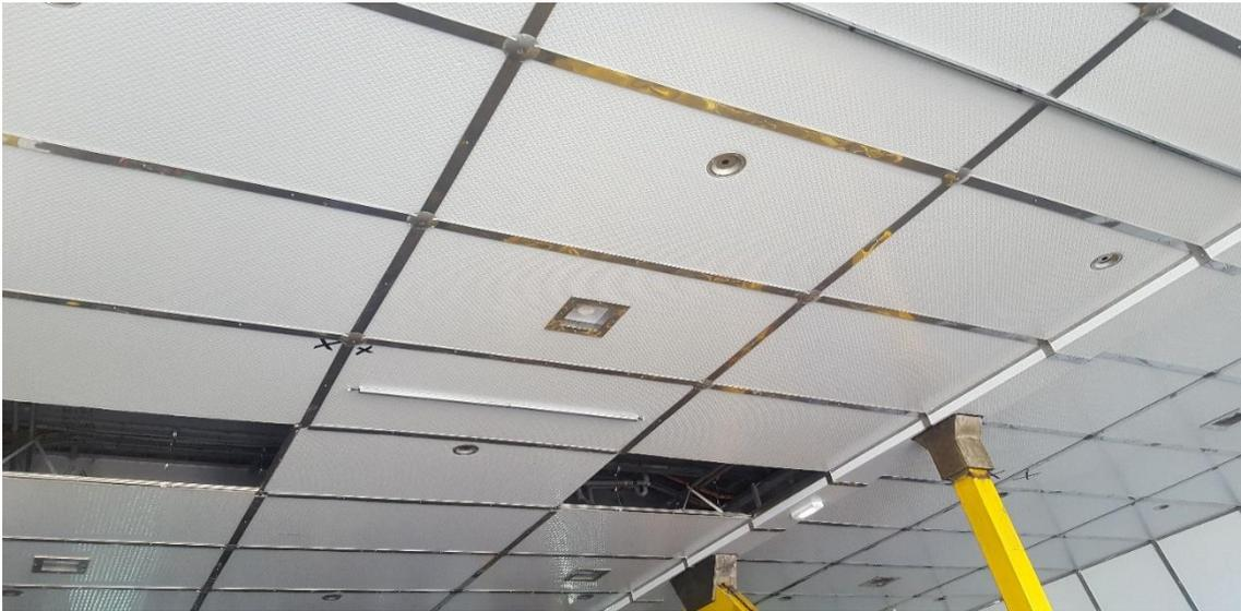
**Ilustración 33: Techo del garaje con lamas A-60. Fuente: Elaboración propia.**
