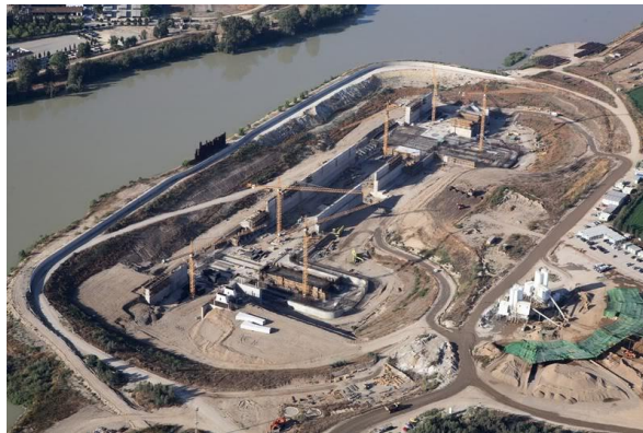
Figura 6: Obras del tercer juego de esclusas del Puerto de Sevilla
