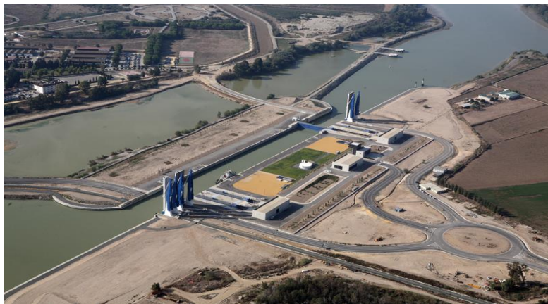
Figura 36: Vista alzada de las esclusas previas a la llegada al puerto de Sevilla
