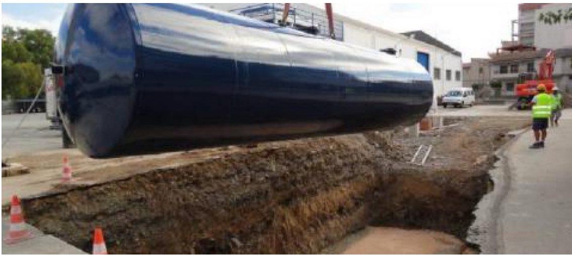
Figura 2.2: Colocación de un tanque de doble pared.
