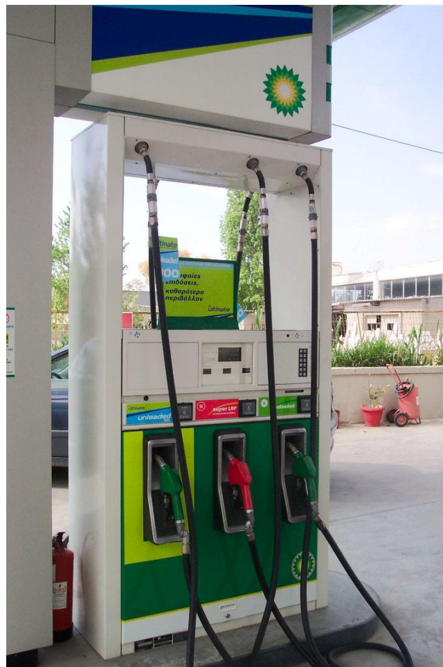
Figura 2.4: Surtidor de combustible.
