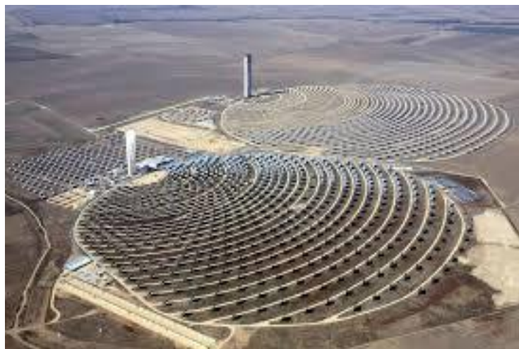
Figura 5: Vista aérea de la Central de Torre PS20[9]
