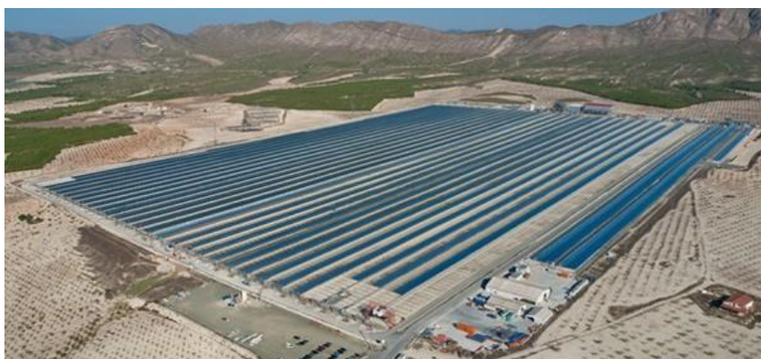
Figura 4: Vista aérea de las centrales Puerto Errado[8]
