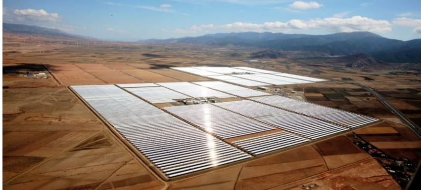
Figura 3: Vista aérea de las centrales Andasol [7]
