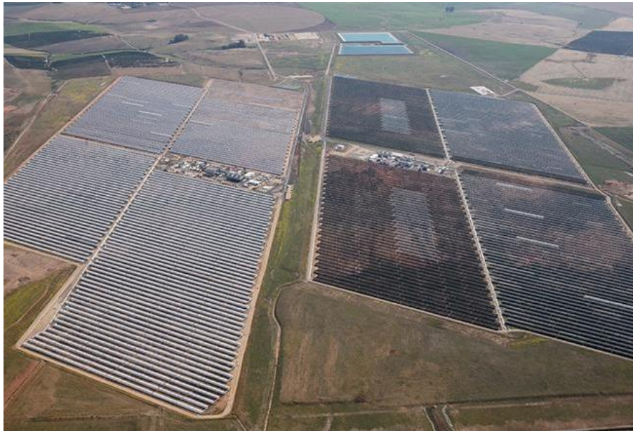
Figura 4: Central termoelectrica Palma del Río I y II Fuente 8: Acciona
