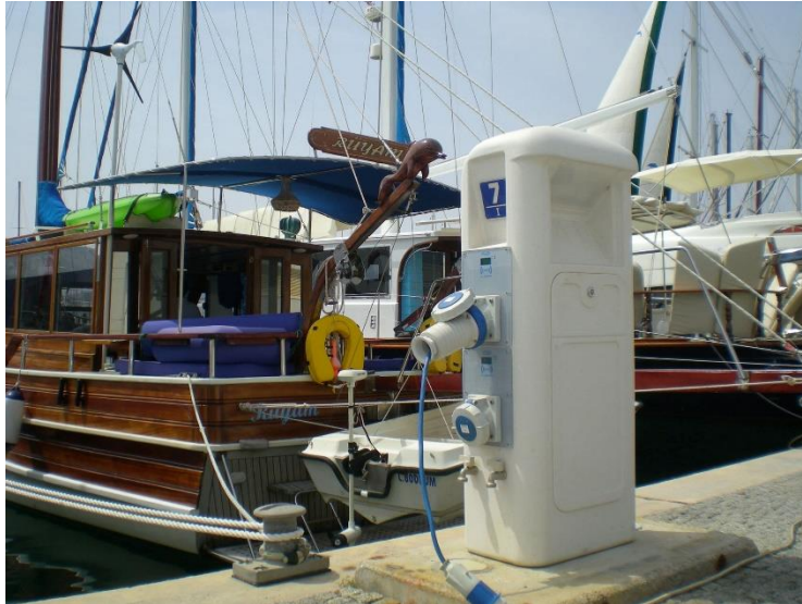
Ilustración 6. Torreta de suministro eléctrico en un puerto deportivo. Fuente: nauticexpo.es
