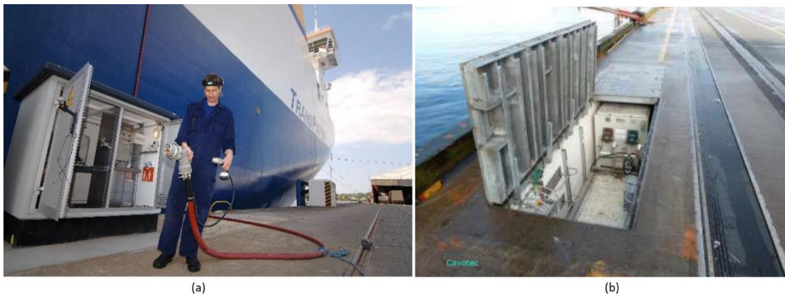
Ilustración 11. Cajas de conexión. (a) Vertical (b) Enterrada. Fuente: poweratberth.eu (16)
