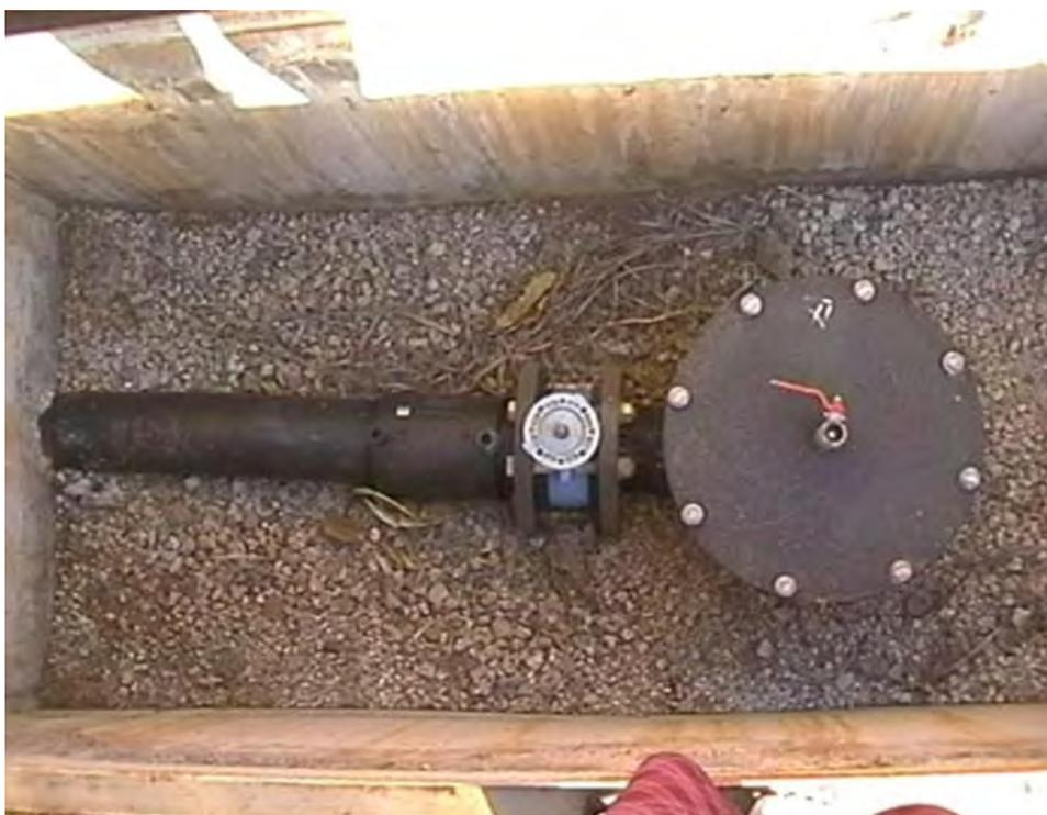
**Figura 3.39.-** Imagen de uno de los pozos del sistema de extracción de biogás del vertedero de Lazareto.
