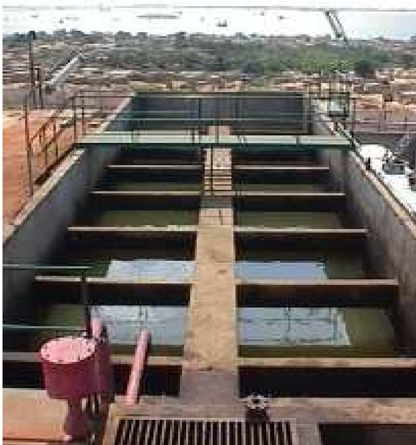
Figura 8.8. Separador Wenco de la Refinería
