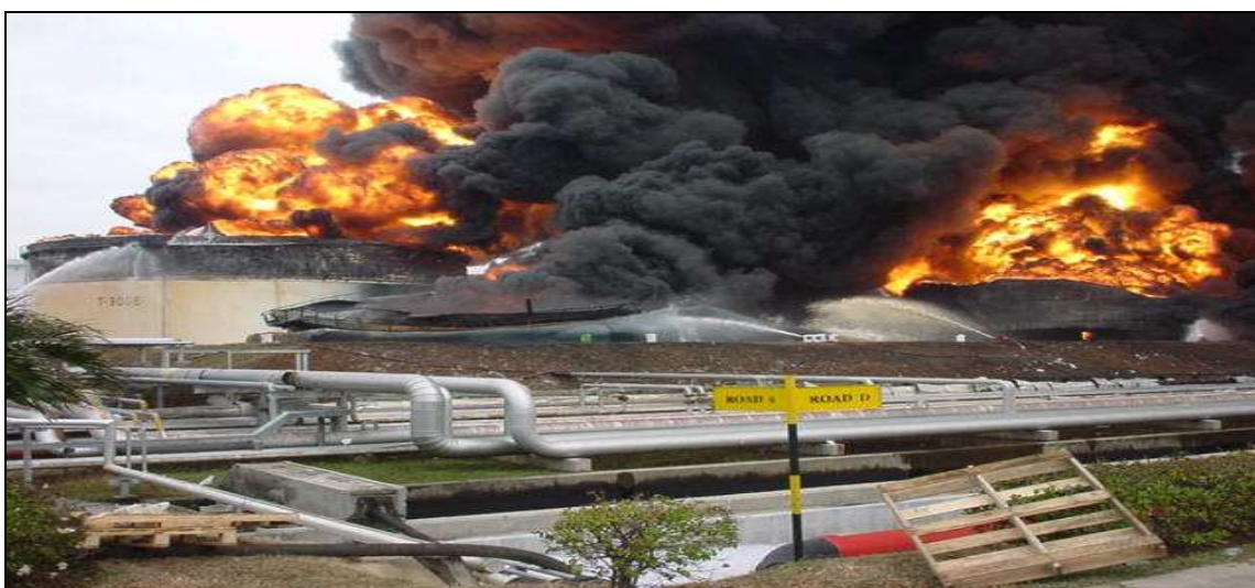
Figura 6.1. Explosión e incendio en la refinería de Luanda
