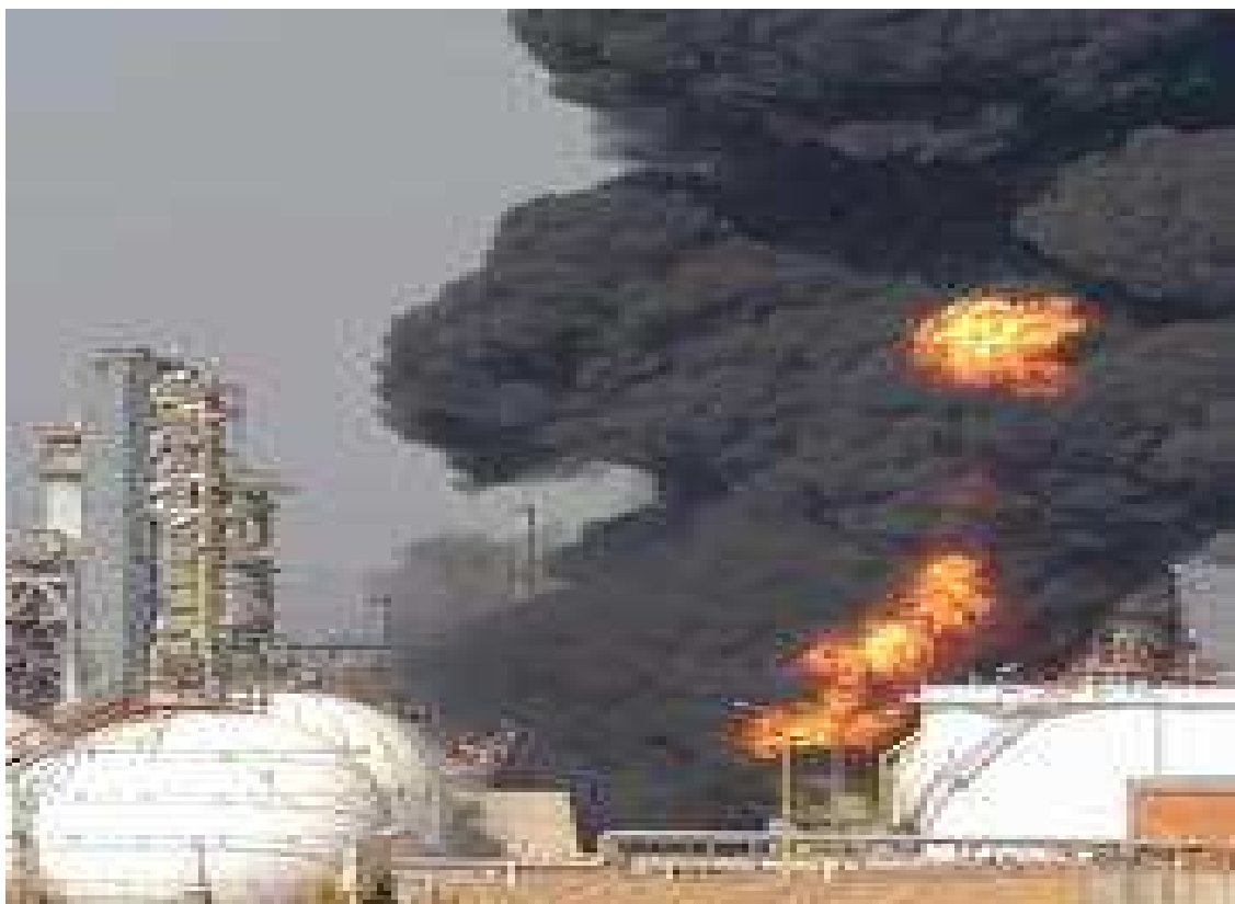
Figura 8.11. Incendio en la refinería de Luanda
