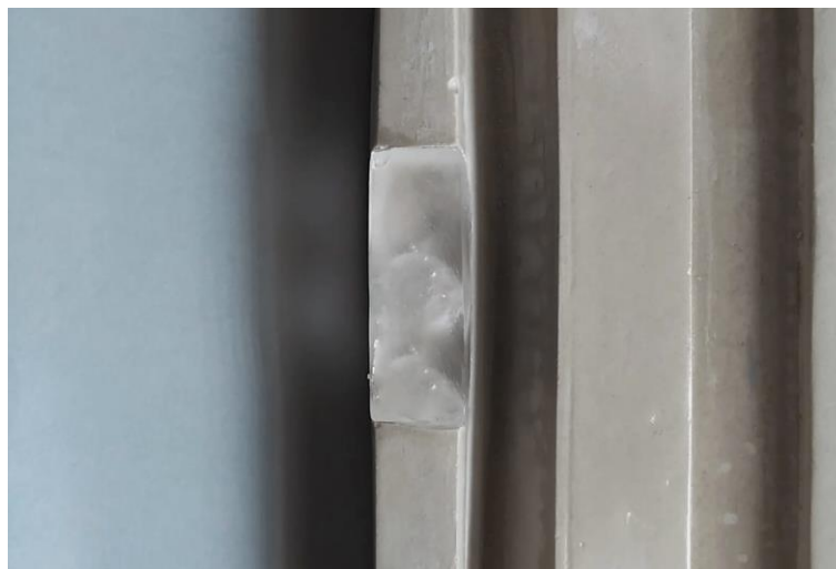
Ilustración 111. Injerto realizado con resina transparente.
