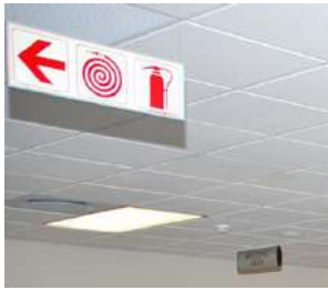
Fig 60: Extracción de señalización interior.
