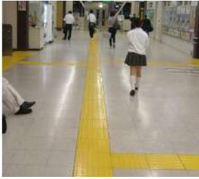
Fig 69: Azulejo con relieve para permitir la movilidad de peronas con discapacidad visual.
