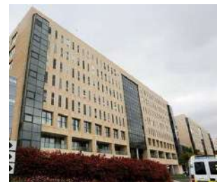
Fig 63: Hospital Universitario Insular.
