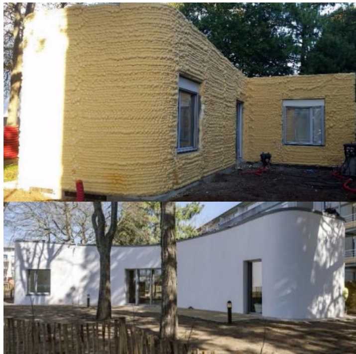
Fig. 55. Yhnova™ sin revestimientos (arriba); Yhnova™ terminada (abajo) [64].
