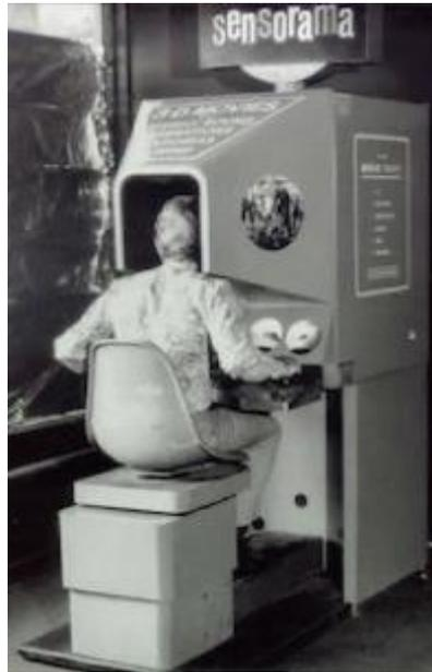
*Figura 5: Simulador de realidad virtual "Sensorama"*
