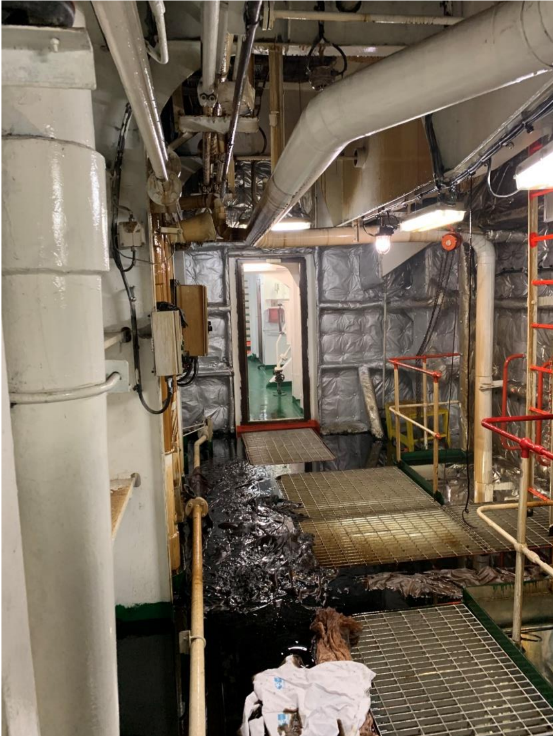
Ilustración 9: Local técnico de popa, primer derrame Elaboración propia
