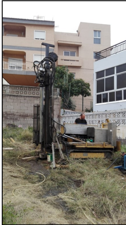
Emplazamiento del sondeo S-1
