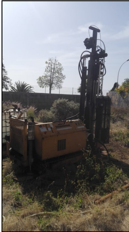
Emplazamiento del sondeo S-2
