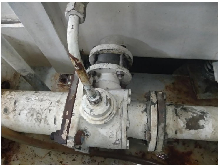
Figura 18. Ejector de aire-salmuera. Elaboración propia.
