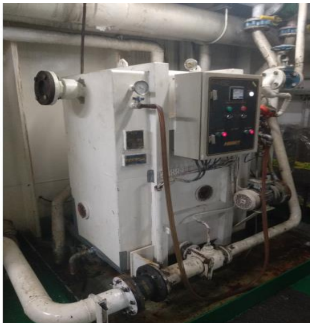
Figura 13. Desaladora del buque "Volcán de Taburiente". Elaboración propia.
