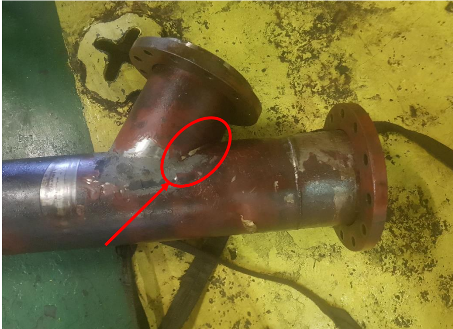
Ilustración 55. Extracción de tubería para reparación
