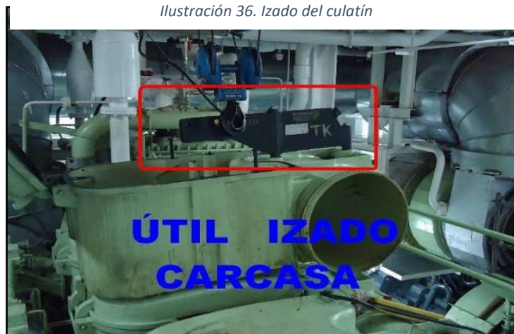
Ilustración 36. Izado del culatín
