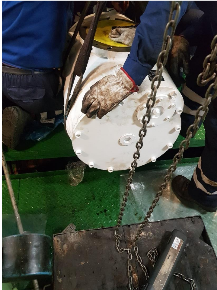
Ilustración 66. Apriete de tornillos de la bomba acoplada de aceite
