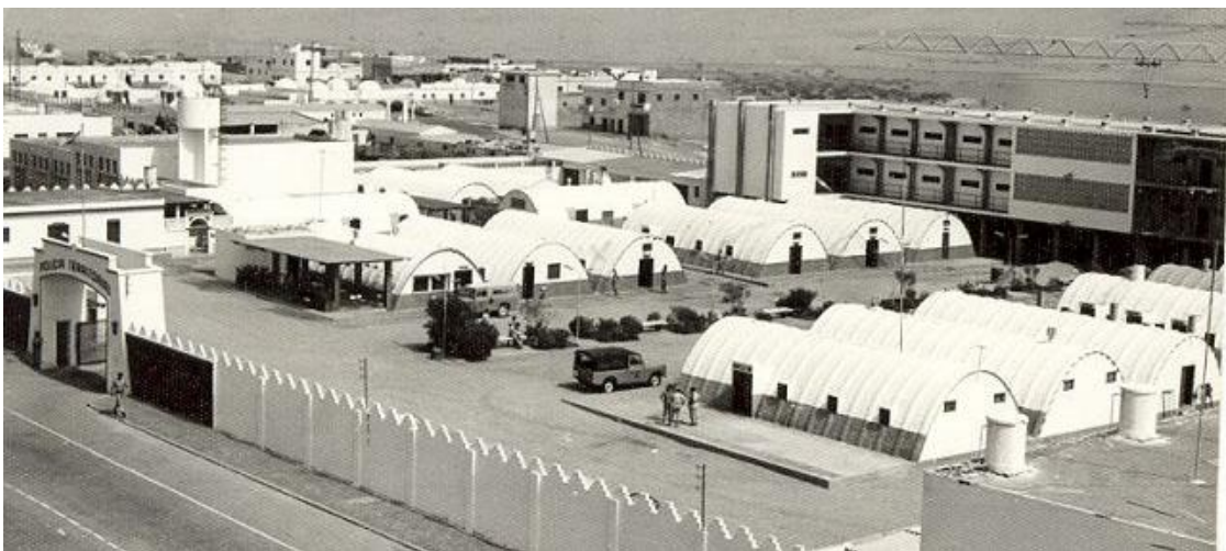
FIGURA 152 . Cuartel Policía Territorial. Vista completa de las instalaciones tras la reforma. Aaiun, 1968
