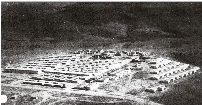
FIGURA 48. Vista aérea del polígono de Colomina en Sidi Ifni. Se puede apreciar tanto la segregación como la jerarquización espacial. Las viviendas de 1ª categoría “A”, daban frente al río y a la ciudad deportiva “General Agulla”.
