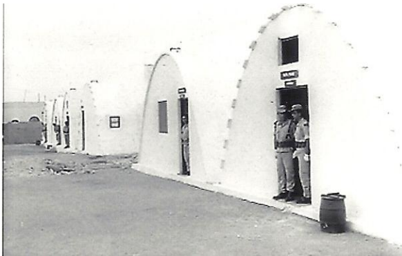
FIGURA 151 . Cuartel de la Policía Territorial de Aaiun. Vista parcial de los barracones catenáricos. 1962.
