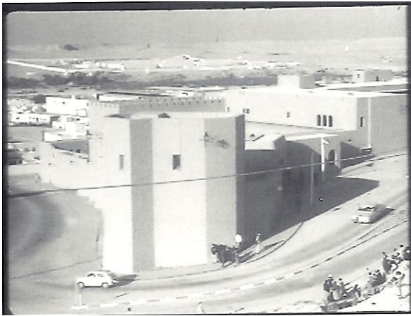
FIGURA 143 . Parador Nacional de Turismo de Aaiun. Se observa la adaptación del edificio al desnivel existente.
