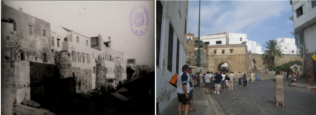
FIGURA 22. A la izquierda se observan las adherencias construidas sobre el lienzo de las murallas. A la derecha vista actual de un tramo de la muralla.
