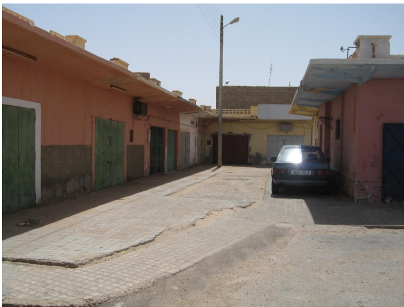
FIGURA 132 .Estado actual del Zoco Viejo. A la derecha tiendas construidas enes visible el mencionado espacio libre del interior.
