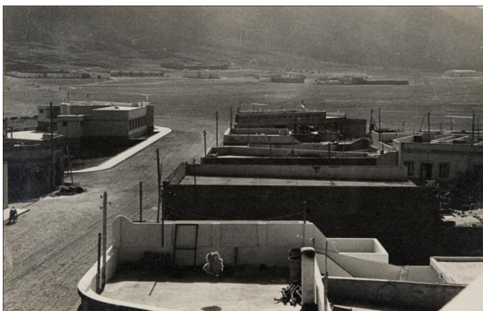
FIGURA 51. Sidi Ifni. En la fotografía se observa la cercanía del caserío urbano con el aeropuerto.
