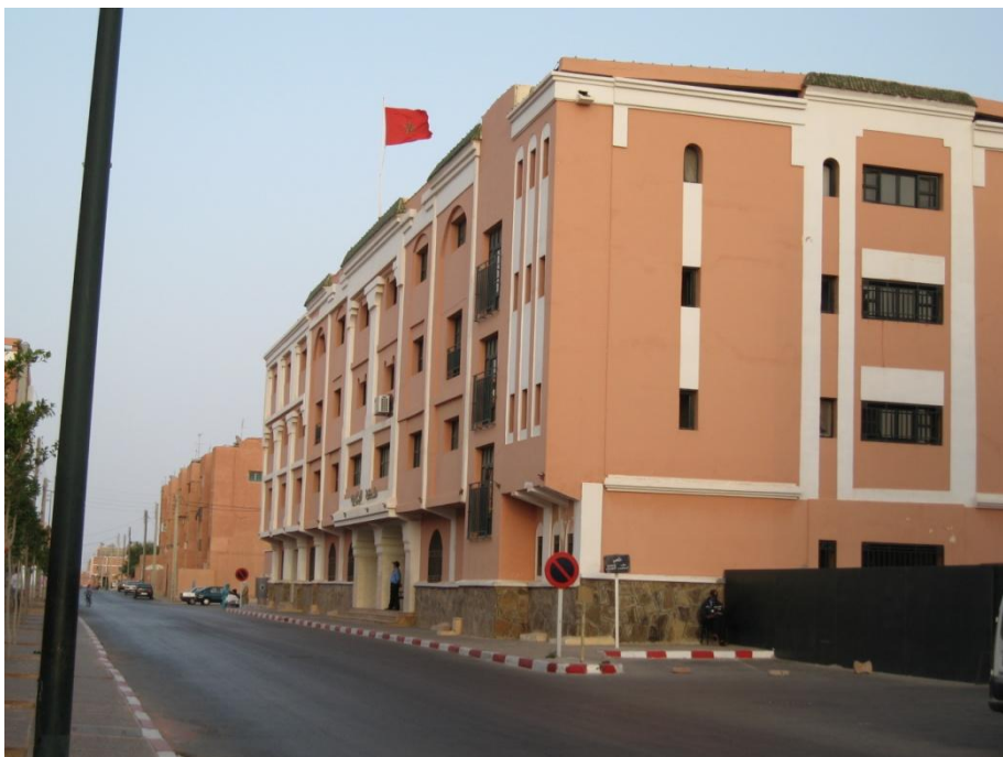
FIGURA 142 . Estado actual del edificio. Sólo es posible reconocer su estructura a través de las vigas de la cubierta y los pilares retrasados de la fachada. Aaiun,2006.
