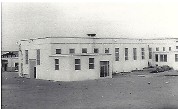
FIGURA 173 . Central eléctrica. Vista posterior del edificio principal con la nave de motores (donde se ubicaban los transformadores) y los dos edificios adosados (talleres, aseos y oficinas).
