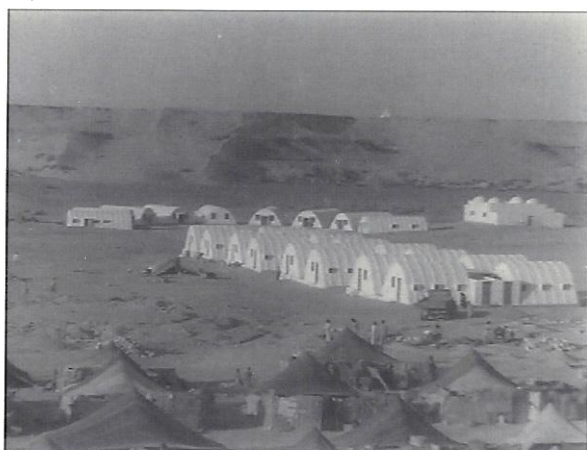
FIGURA 166 . Los cuatro bloques catenáricos del barrio de Obreros.
