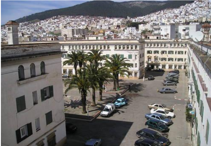
FIGURA 32. Tetuán. Estado actual de los Pabellones Varela.
