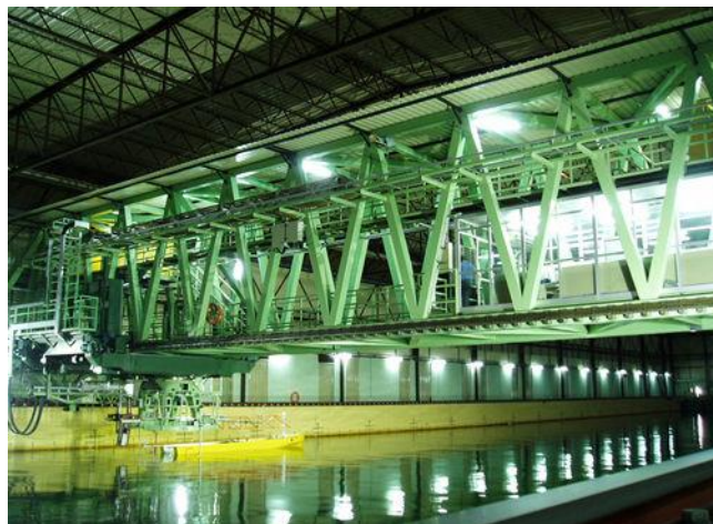
Ilustración 20. Canal de Experiencias Hidrodinámicas de El Pardo. Fuente: www.inta.es
