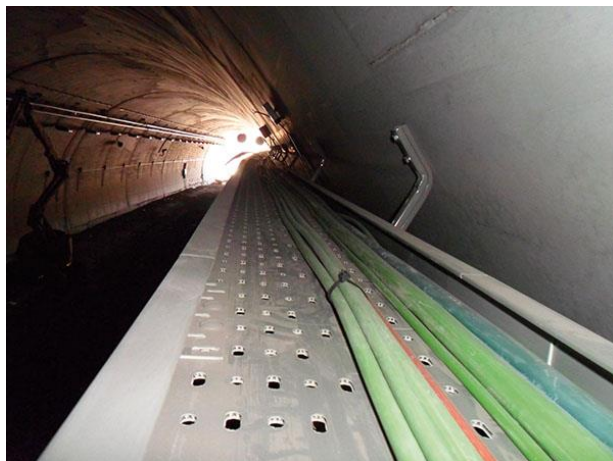
Ilustración 28. Cables instalados en bandeja perforada dentro de un aerogenerador. Fuente: Google imágenes.
