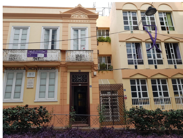
El edificio de la Escuela Montessori. En la C/ Emilio Calzadilla. Sta Cruz de Tenerife.
