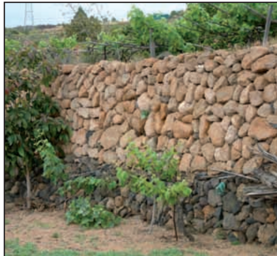
Los bloques de tosca se emplean como elementos de construcción en casas y muros de cultivos.
