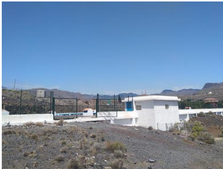
Figura 7.16: Imagen del depósito de La Hoya 2. Fuente: camaradeaguas.com
