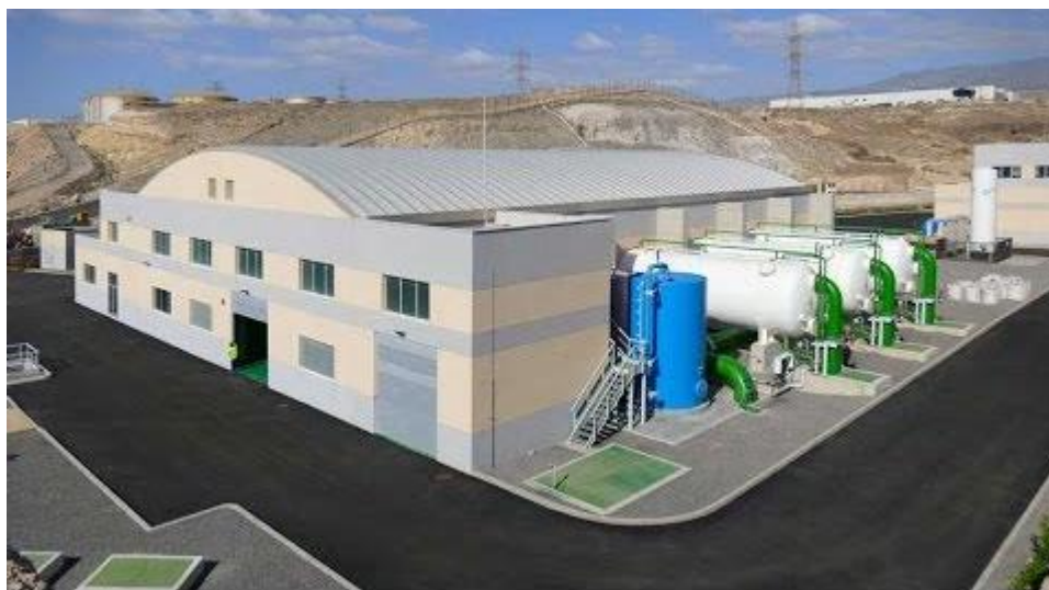
Figura 3.6: Estación desaladora de Granadilla de Abona en la actualidad. Fuente: fcca.es
