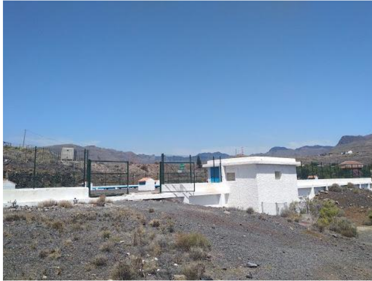
Figura 3.1: Imagen del depósito de La Hoya 2. Fuente: camaradeaguas.com
