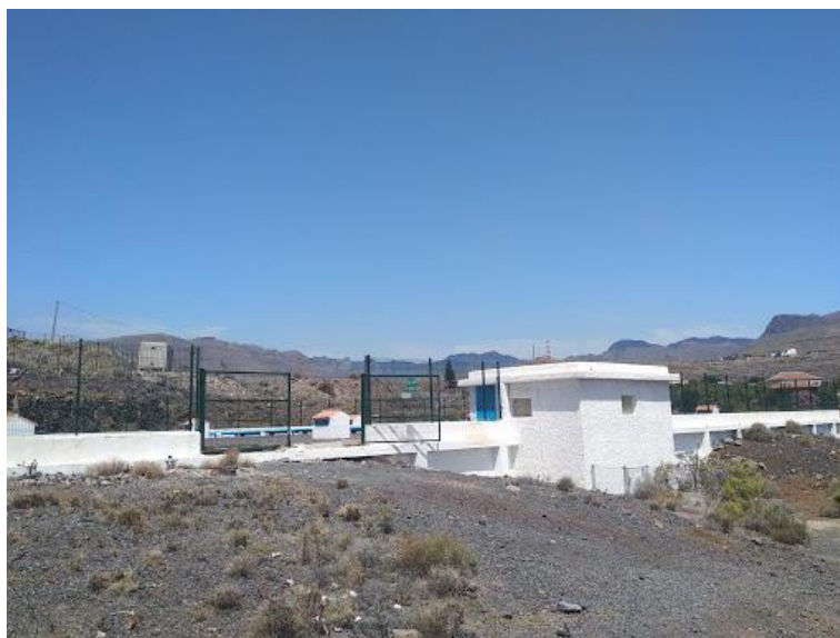
Figura 8.3: Imagen del depósito de La Hoya 2. Fuente: camaradeaguas.com
