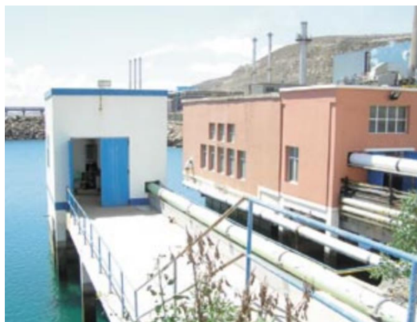
Figura 3.2: Captación de agua de mar mediante toma abierta. Desaladora Las Palmas III. Fuente: Guía de desalación.
