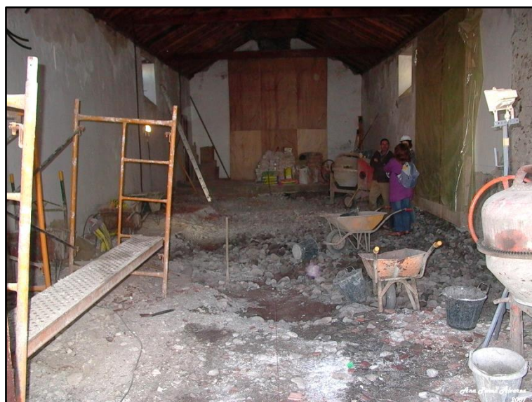
Lámina 2.17.- Aspecto que presentaba el interior de la Iglesia de San Andrés cuando fuimos a hacer el informe de impacto en enero de 2007 (La Caleta de Interián, Garachico) (fotografía ARPA)
