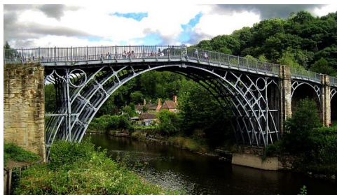
Ilustración 8. Puente Shropshire sobre el río Severn. Fuente: alamy.es
