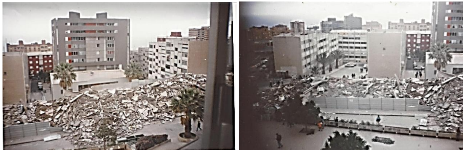
Figura 26. Derribo de los bloques originales de Santa Clara. Imágenes de 1996
