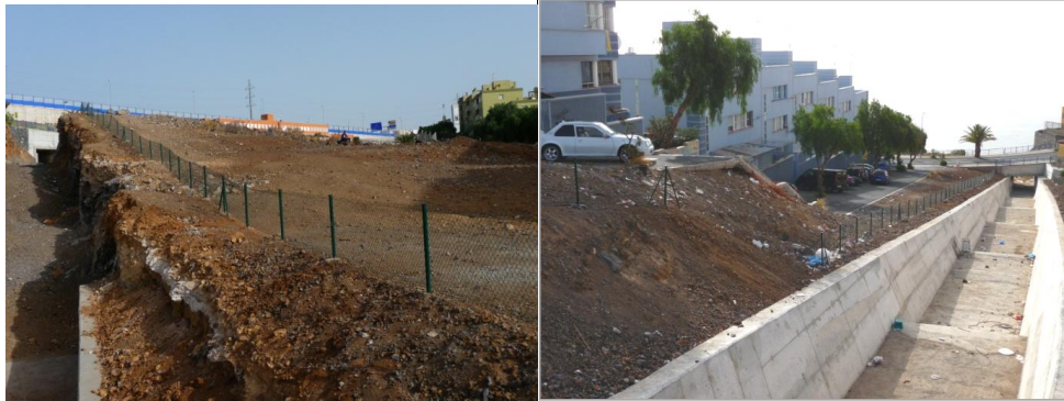
Figura 39. Espacios libres sin ejecutar del barrio de Añaza
