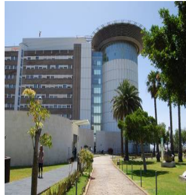
Figura 4. Hospital Universitario de Canarias
