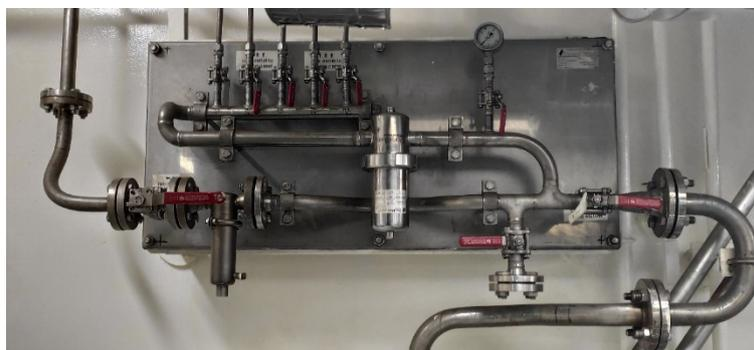
*Ilustración 23: Unidad de distribución y control de presión*
