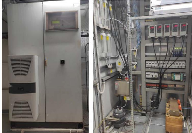
*Ilustración 36: Armario del analizador de NO<sub>x</sub>*
