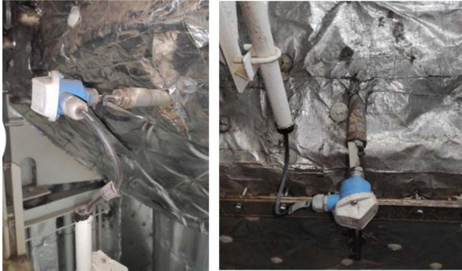
*Ilustración 46: Sensores de temperatura a la entrada y salida del reactor*
