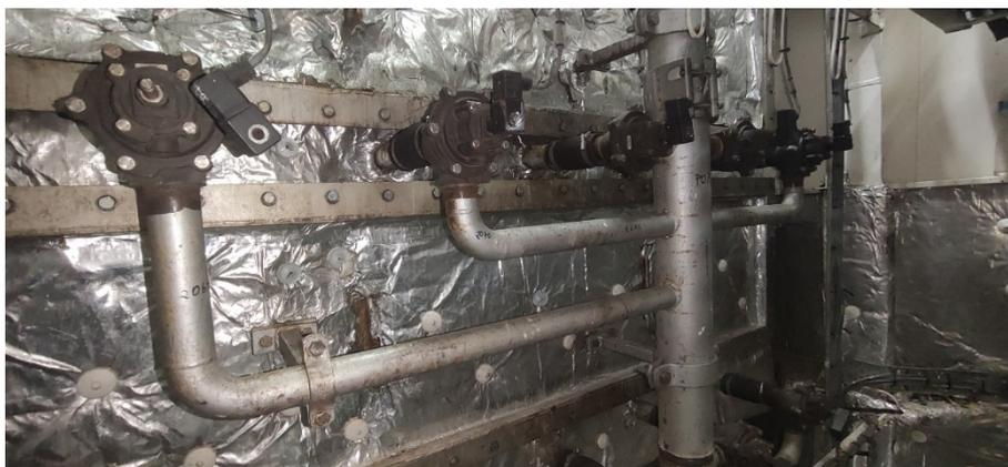
*Ilustración 45: Válvulas de soplado de hollín del reactor*
