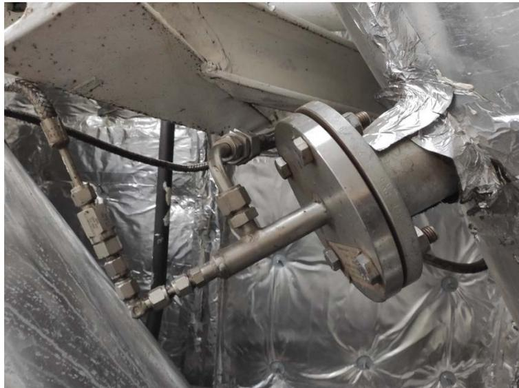
Ilustración 27: Lanza de inyección
