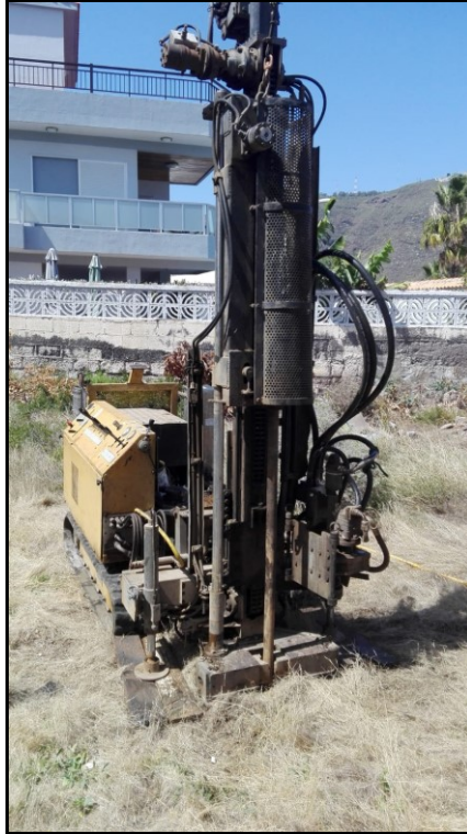
Emplazamiento del DPSH-1
