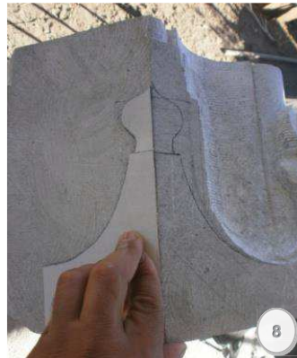
Figura 8.- Transferencia de la plantilla a la piedra.
