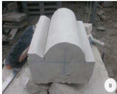
Figura 9.- Eliminación de las aristas de los chaflanes, conformándose la superficie curva.
