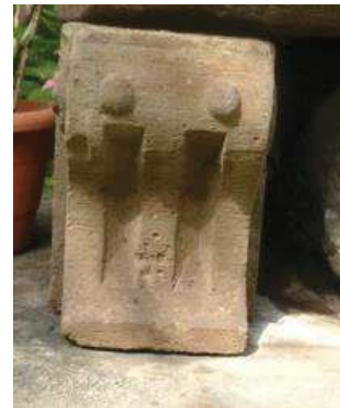
Figura 19.- Frente de los basamentos de las ménsulas.
