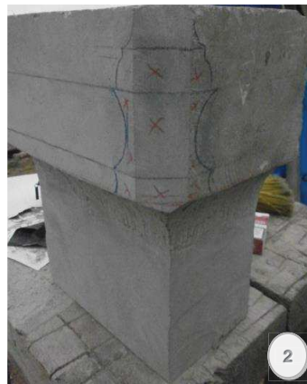
Figura 2.- Emplantillado del ábaco. Selección con marcas en cruz de color rojo del material a eliminar.
