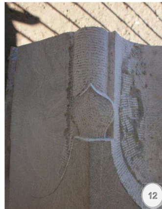
Figura 12.- Desbaste y encajado del adorno.
