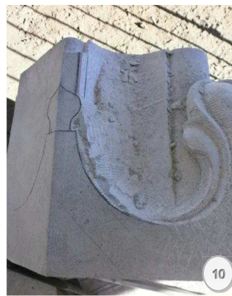
Figura 10.- Desbaste del contorno y molduras.
