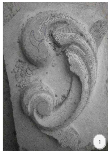
Figura 1.- Profundizado de los nervios de las hojas abiertas.
