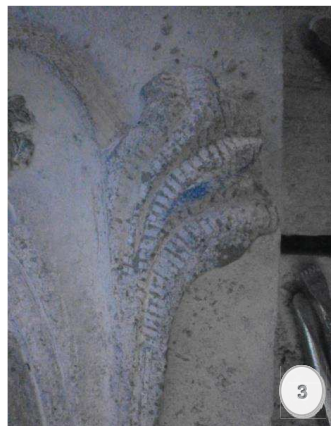
Figura 3.- Detalle, conjunto de hojas exteriores, encajadas y modeladas a gradina.
