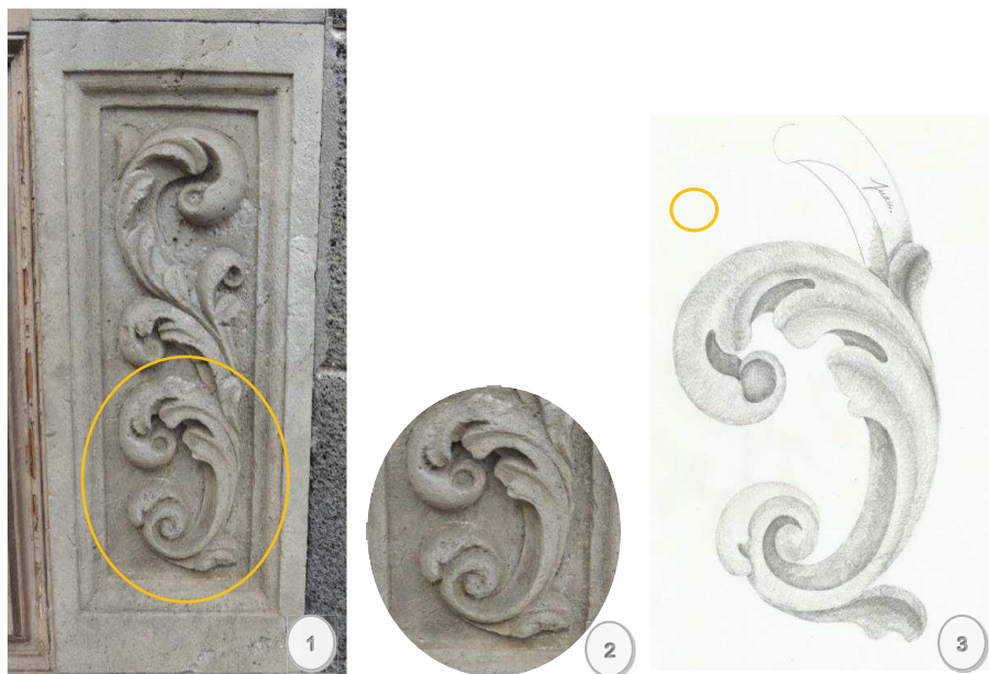
Figuras 1.- Pedestal de la hornacina de la portada de la iglesia de San Luis Gonzaga. 2.- Selección de unos de los motivos de la parte inferior de la composición. 3.- Esquema de diseño del motivo seleccionado y disposición de los volúmenes/claroscuros (plantilla).
