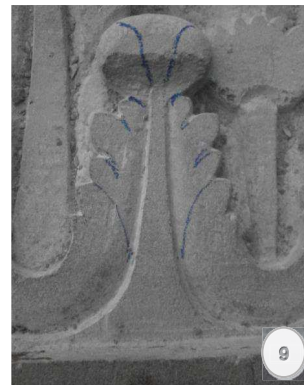
Figura 9.- Labra del nervio central y trazado de los denticulos.
