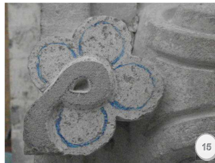
Figura 15.- Trazado del chanfleado exterior de los pétalos.
