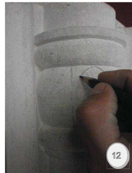
Figura 12.- Fijación con lápiz del trazado para una mejor definición.
