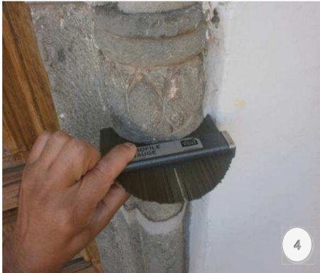
Figura 4.- Tama de medidas de los diferentes volúmenes de los que se compone el capitel.
