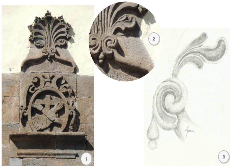
Figuras 1.- Motivos ornamentales de la parte central del frontón de la portada de la iglesia de San Francisco. 2.- Selección de uno de los motivos de la composición. 3.- Esquema de diseño del motivo seleccionado y disposición de los volúmenes/claroscuros (plantilla).
