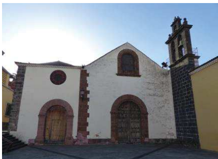
Figura 11.- Fachada del convento de Santo Domingo de La Laguna. Tenerife. Fotografía tomada en 2014.
