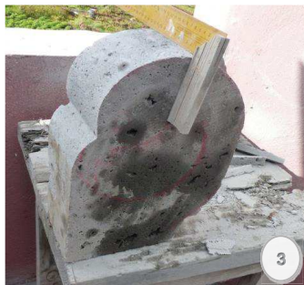
Figura 3.- Labrado del contorno del motivo ornamental.
