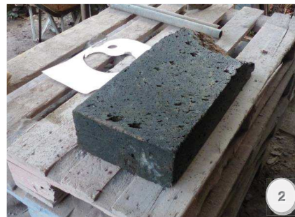
Figura 2.- Labrado de los cinco paramentos del bloque y a escuadra de todas sus caras.
