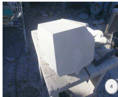
Figura 4.- Labrado de los cinco paramentos del bloque y a escuadra de todas sus caras.
