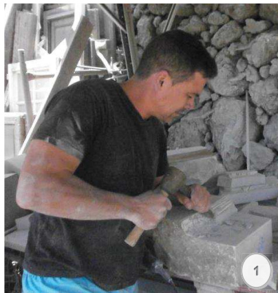
Figura 1.- Desbaste de la moldura inferior del ábaco.
