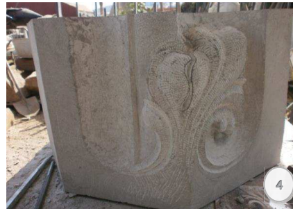
Figura 4.- Modelado de las formas con cinceles y gubias.
