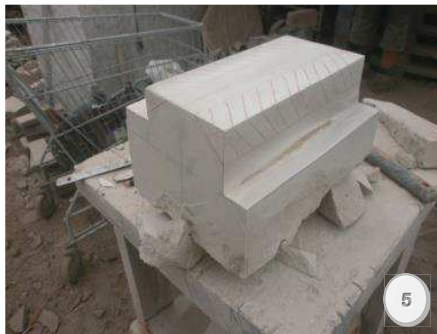
Figura 5.- Rebajes realizados y trazado de los chaflanes.
