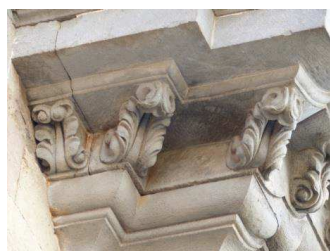
Figura 10- Detalle de la cornisa izquierda.
