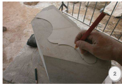
Figura 2.- Transferencia de la plantilla a la piedra.
