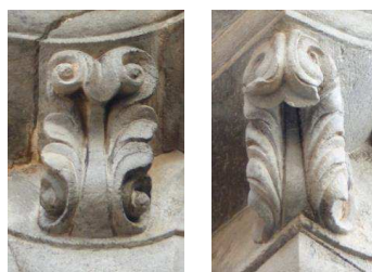
Figura 11.- Vistas de las ménsulas.
