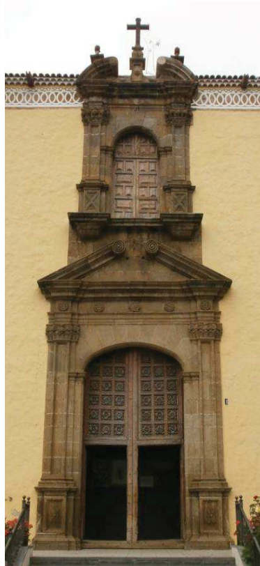
Figura 1.- Portada de la iglesia de San Agustín de La Orotava, siglo XVII. Fotografía tomada en el 2014.
