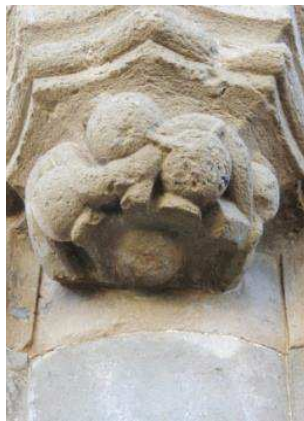
Figura 10.- Figura- Detalle, ménsula izquierda.
