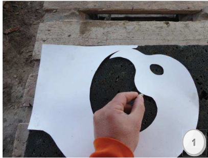
Figura 1.- Transferencia de la plantilla a la piedra.
