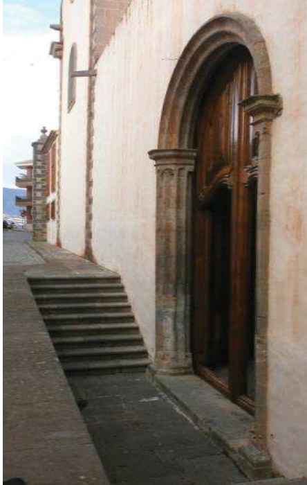
Figura 1.- Portada Sur de la iglesia de La Concepción. Fotografía tomada en 2014.
