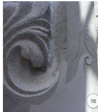
Figura 16.- Transferencia de la plantilla a la piedra.
