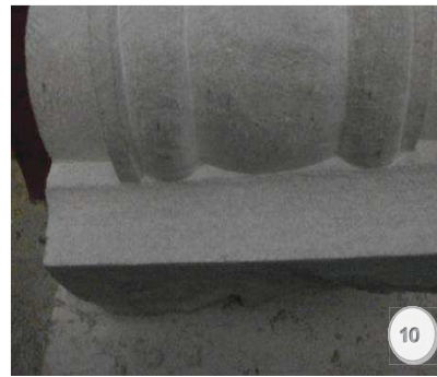
Figura 10.- Acabado superficial con gubia de la moldura interior de la dovela.
