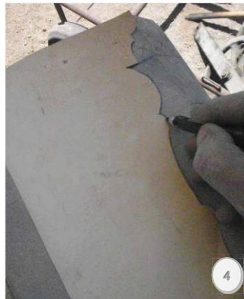
Figura 4.- Trazado de los cortes de la moldura del ábaco.
