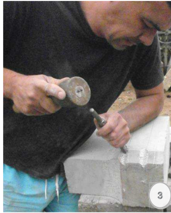
Figura 3.- Desbaste de las molduras.
