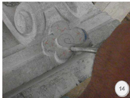
Figura 14.- Roseta . Selección con marcas en cruz de color rojo del material a eliminar.
