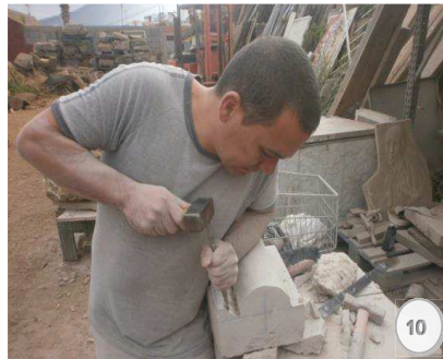
Figura 10.- Labra de la moldura exterior de la dovela.
