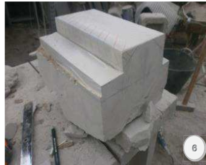
Figura 6.- Rebajes realizados y trazado de los chaflanes.
