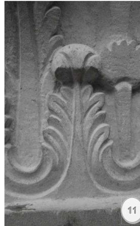
Figura 11.- Labra de los detalles y acabado superficial con gubias.
