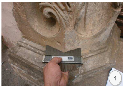
Figura 1.- Toma de medidas de la configuración volumétrica y de las diferentes secciones.
