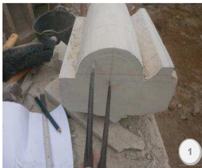
Figura 1.- Trazado de los costados del diámetro total del baquetón.
