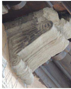
Figura 16.- Canalón de la parte de izquierda.
