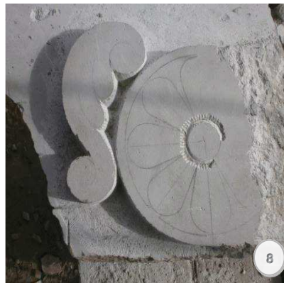
Figura 8.- Vista frontal del exterior del botón central de la roseta y recorte interior del motivo vegetal.
