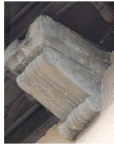
Figura 17.- Canalón de la parte de derecha.
