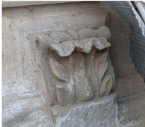
Figura 16.- Ménsulas de la cornisa.
