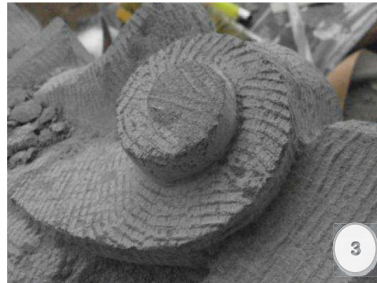
Figura 3.- Desbaste de la rosca de la voluta.
