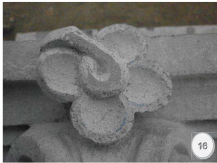
Figura 16.- Desbaste y definición de las formas.
