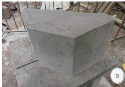
Figura 3.- Vista del tazado del bloque.
