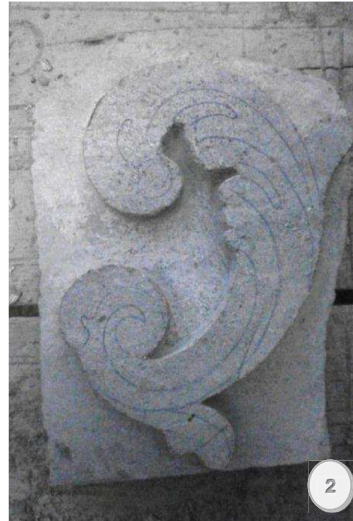
Figura 2.- Vista frontal del recorte y fondeado del motivo ornamental.
