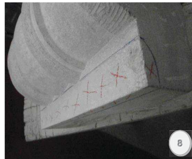
Figura 8.- Vista del tazado de la moldura interior y selección con marcas en cruz de color rojo del material a eliminar.
