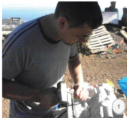
Figura 1.- Desbaste del sobrante de la primera y segunda fila de hojas de acanto.
