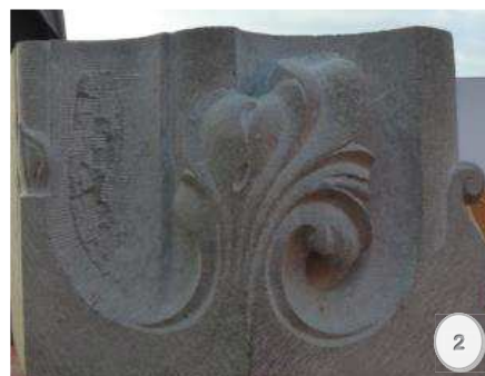
Figura 2.- Elemento ornamental ejecutado.
