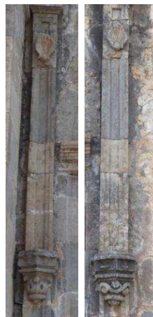
Figura 34.- Ménsulas y veneras de la portada de la nave de la Epístola de la iglesia de La Concepción del Realejo Bajo.
