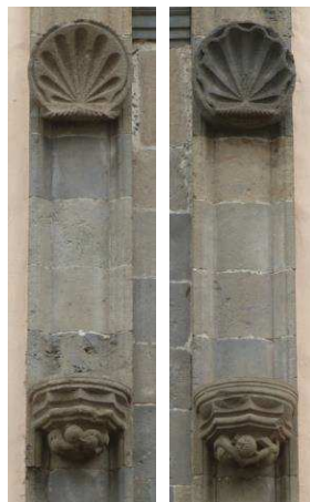
Figura 33.- Ménsulas y veneras de la portada Norte de la iglesia de La Concepción de La Orotava.
