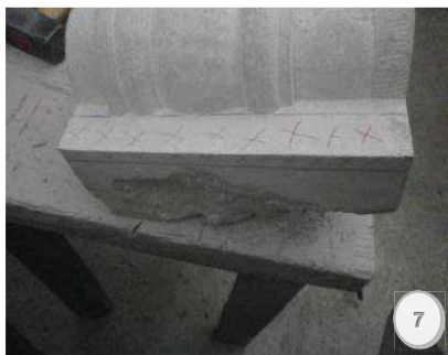
Figura 7.- Acabado superficial mediante gubias y cincelos. Labra de la moldura interior de la dovela.
