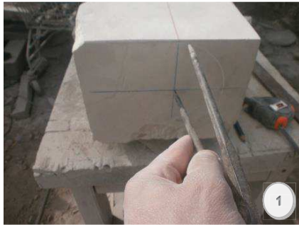
Figura 1.- Transferencias a la piedra de las medidas tomadas en el capitel original.
