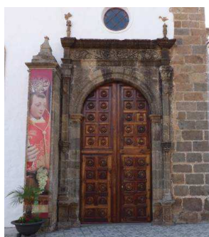
Figura 28.- Portada de la nave de la Epístola de la iglesia de La Concepción del Realejo Bajo, mediados del siglo XVI. Fotografía tomada en 2015.
