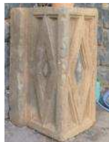
Figura 10.- Pedestal y columna de la portada de la Casa Llarena Carrasco de La Orotava.
