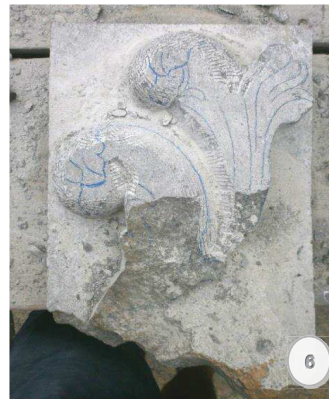
Figura 6.- Labra y modelado de los contornos, motivos inferior y superior.
