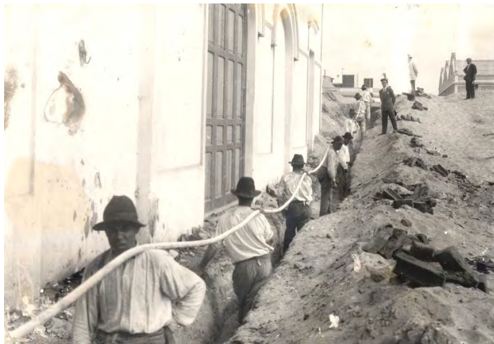
Figura 6.1: Tendidos en las capitales canarias. Obras en la zona del Puerto en Las Palmas de Gran Canaria (ca. 1927).
