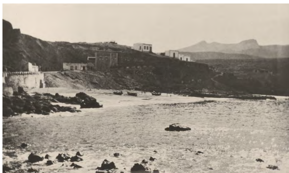
Figura 6.10. Tendido del cable interinsular, Sardinia (Cáldar) 1930.
