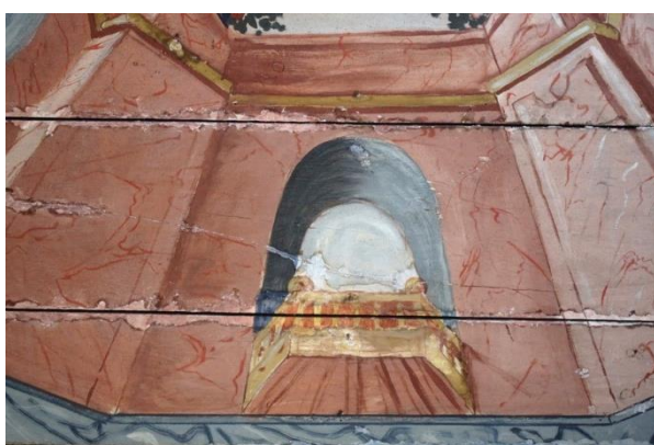
Fig.152. Detalle de la zona central del techo antes de la reintegración cromática con goma arábica y pigmentos.
