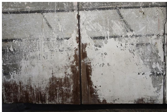
Fig.56. Detalle de la parte baja de la puerta de la Epístola, en la que se aprecia falta de policromía y la laguna que se crea en la superficie.
