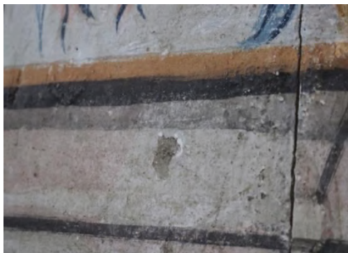
Fig.89. Detalle de la acumulación de cera sobre la policromía antes de la limpieza.
