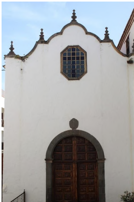
Fig.4. Fotografía frontal de la fachada de la Capilla de los Dolores.
