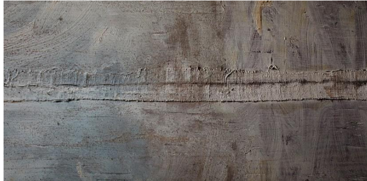
Fig.38. Ejemplo de las telas encoladas colocadas entre las uniones de las tablas.
