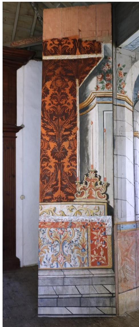
Fig.28. Imagen general puerta izquierda después de la intervención.
