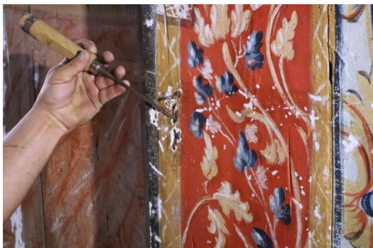
Fig.103. Utilización de un destornillador para separar los clavos.
