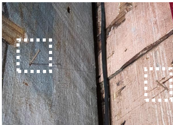
Fig.100. Clavos industriales en el soporte.
