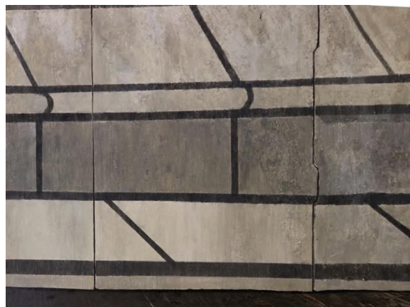
Fig.151. Detalle de la puerta de la Epístola, después de la reintegración cromática con goma arábica y pigmentos.
