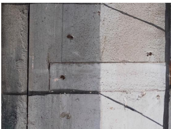
Fig.85. Imagen general del techo durante la limpieza, mitad izquierda limpia y mitad derecha con suciedad superficial.
