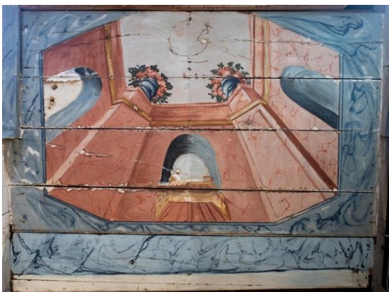
Fig.85. Imagen general del techo durante la limpieza, mitad izquierda limpia y mitad derecha con suciedad superficial.
