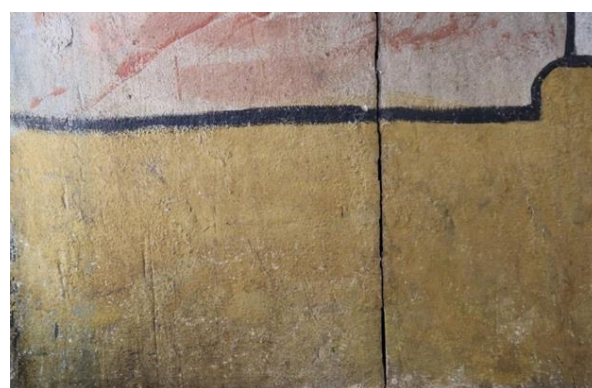
Fig.147. Detalles de manchas de humedad y estucado en el rodapié, Epístola, después de la reintegración cromática con goma arábica y pigmentos.
