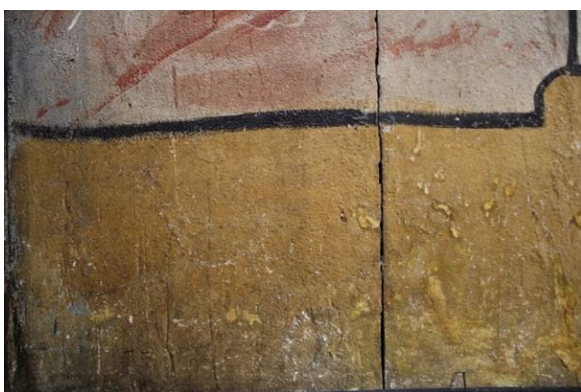
Fig.146. Detalles de manchas de humedad y estucado en el rodapié, Epístola, antes de la reintegración cromática con goma arábica y pigmentos.
