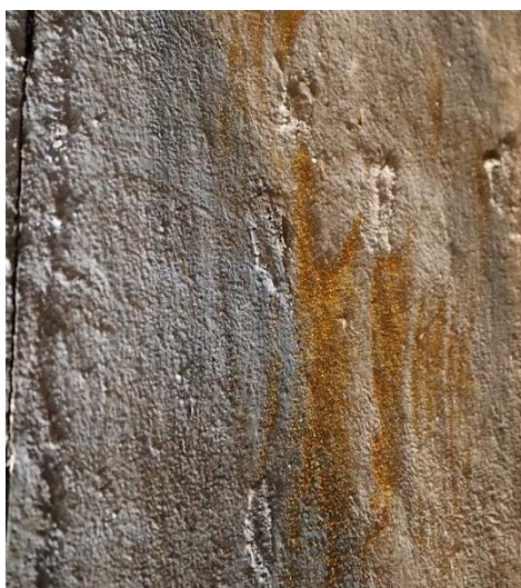
Fig.37. Ejemplo de la exudación de la resina en superficie
