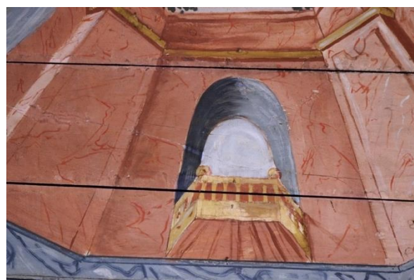
Fig.153. Detalle de la zona central del techo después de la reintegración cromática con goma arábica y pigmentos.
