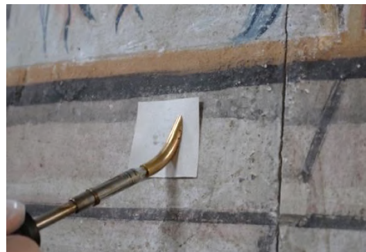
Fig.90. Aplicación de calor con la espátula térmica.
