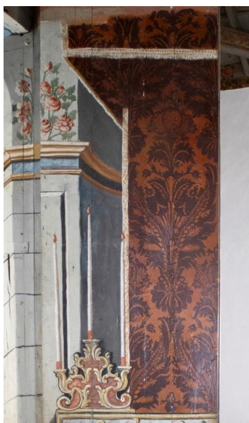
Fig.81. Adamascado de la puerta derecha antes de la limpieza.
