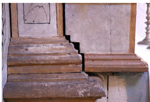
Fig.16. Detalle del perfil del banco superponiéndose a la moldura del banco.
