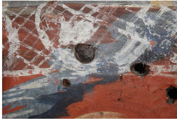
Fig.44. Ejemplo de los clavos hallados y los orificios con falta de los mismos.
