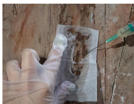
Fig.66. Aplicación de cola de conejo en agua (1:6).
