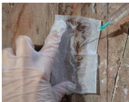
Fig.65. Aplicación del agua y alcohol etílico.
