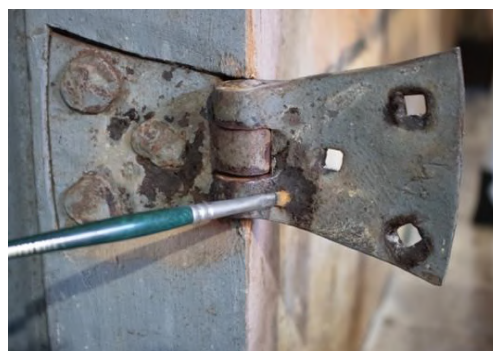
Fig.98. Aplicación de Paraloid® B-44 al 3% en disolvente nitrocelulósico.
