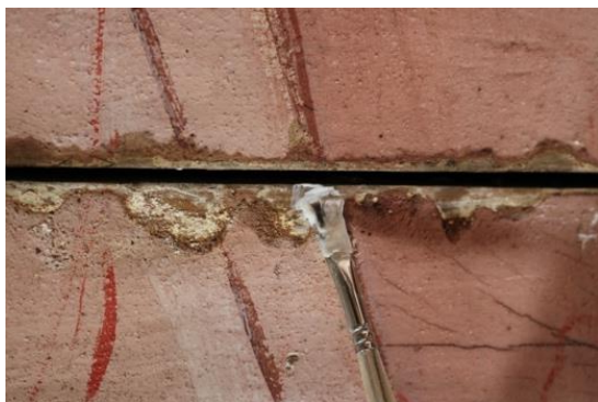
Fig.122. Aplicación de estuco en el techo.
