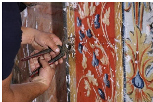
Fig.104. Utilización de pinzas para extraer los clavos.
