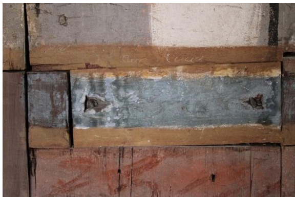
Fig.144. Detalle de Manchas de humedad causadas por el agua en el panel interior, Epístola, antes de la reintegración cromática con goma arábica y pigmentos.
