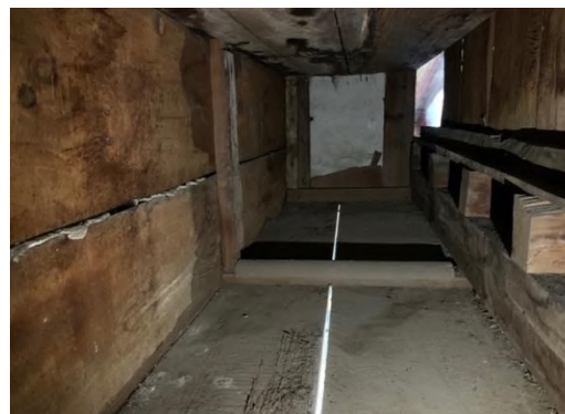
Fig.94. Zona intermedia entre el ático y el techo de la Hornacina, después de la limpieza con aspiradora.
