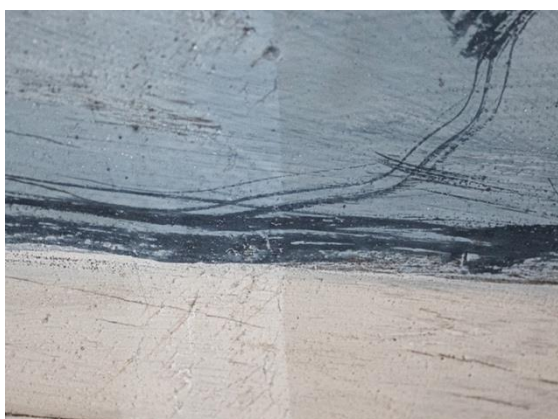
Fig.86. Detalle del techo durante la limpieza, mitad izquierda limpia y mitad derecha con suciedad superficial.
