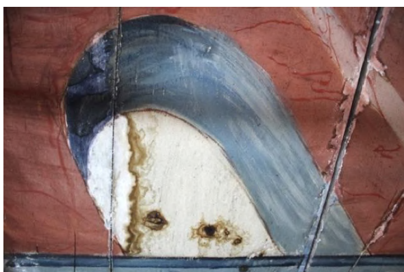
Fig.148. Detalles de manchas de humedad y estucado antes de la reintegración cromática con goma arábica y pigmentos.
