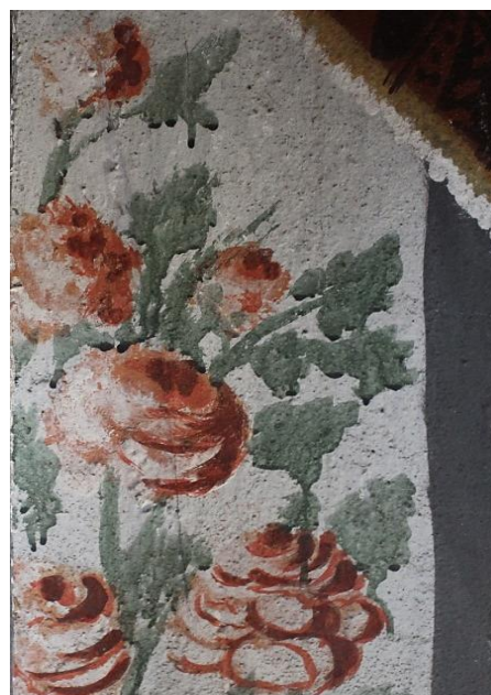
Fig.50. Ejemplo de la técnica del chorreo mal aplicado.
