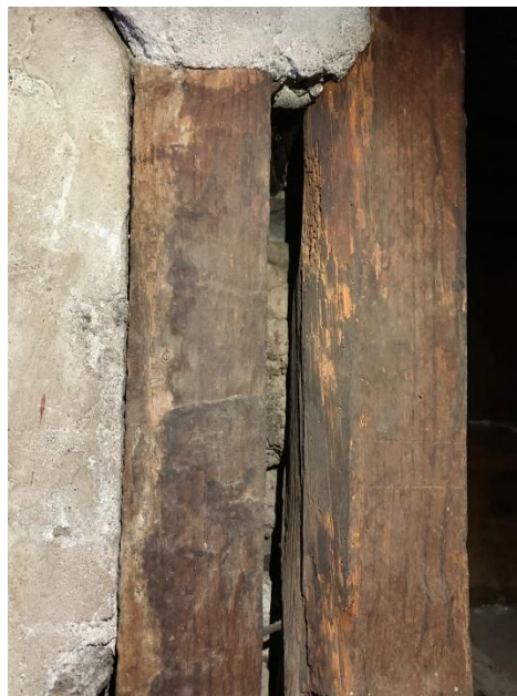
Fig.22. Techo de la Hornacina, material de relleno.
