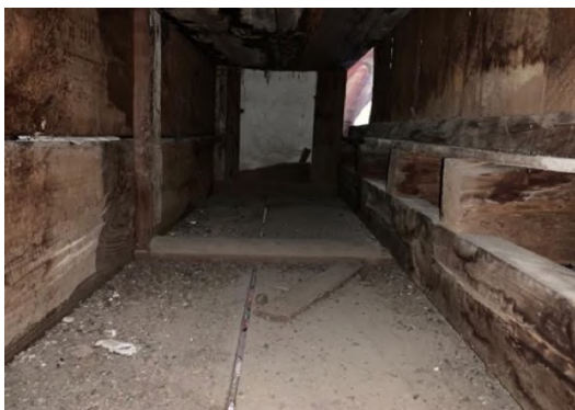
Fig.93. Zona intermedia entre el ático y el techo de la Hornacina, antes de la limpieza con aspiradora.
