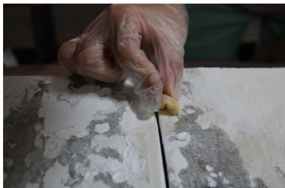
Fig.121. Realización de textura sobre la puerta derecha con estuco y una esponja.
