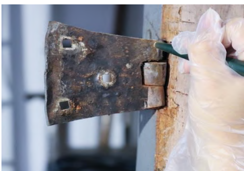
Fig.97. Limpieza de una bisagra con un lápiz de fibra de vidrio.
