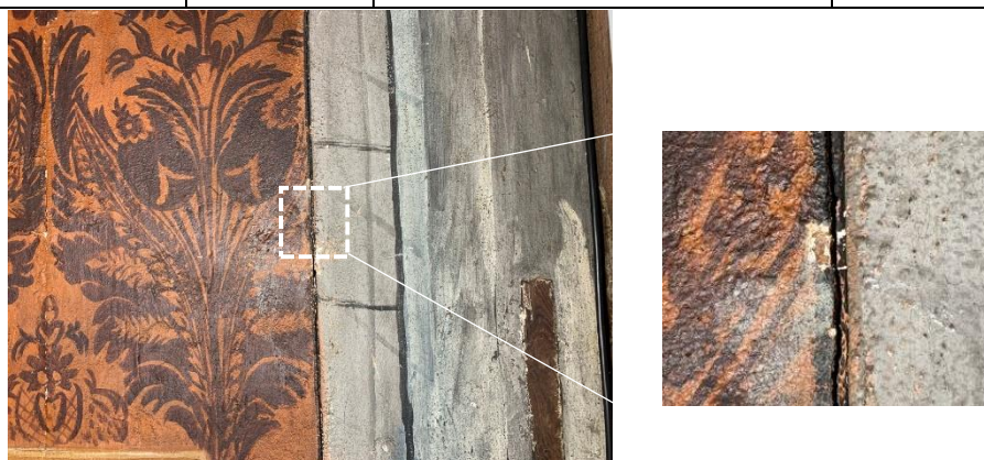
Fig.61. Zona de extracción de la muestra del adamasado.
