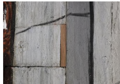
Fig.117. Reintegración con madera de tea finalizada.
