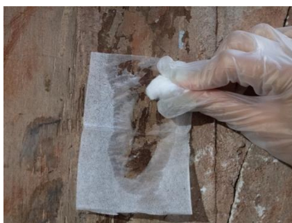
Fig.67. Absorción del exceso de cola con un algodón.
