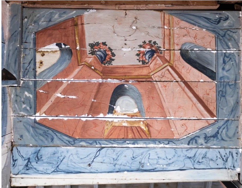
Fig.128. Imagen general del techo estucado y desestucado.
