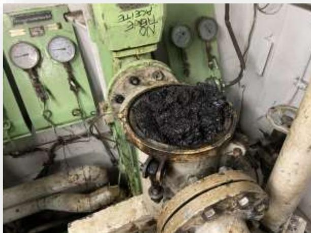
**Ilustración nº72.** Línea de aspiración de la bomba de lodos
