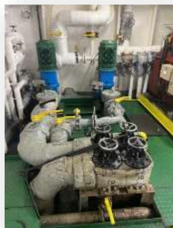
**Ilustración nº60.** Válvulas de trasiego de combustible y de consumo
