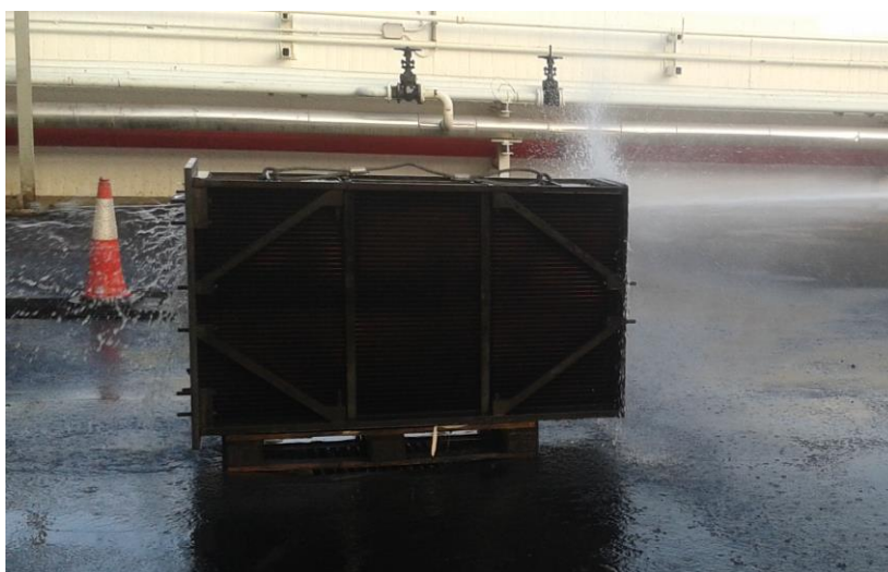
Ilustración 26. Limpieza de enfriador con agua a presión
