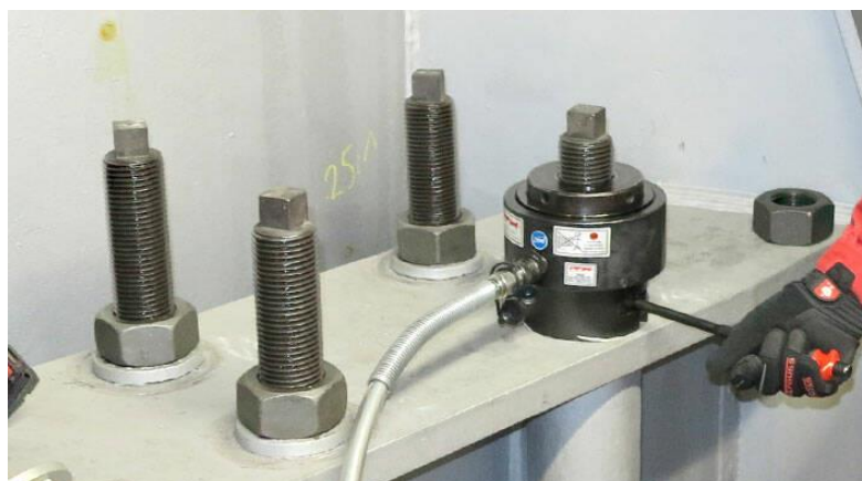
Ilustración 33. Montaje para apriete por estiramiento
