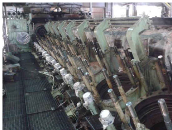
Ilustración 10. Piso de culatas desmontado
