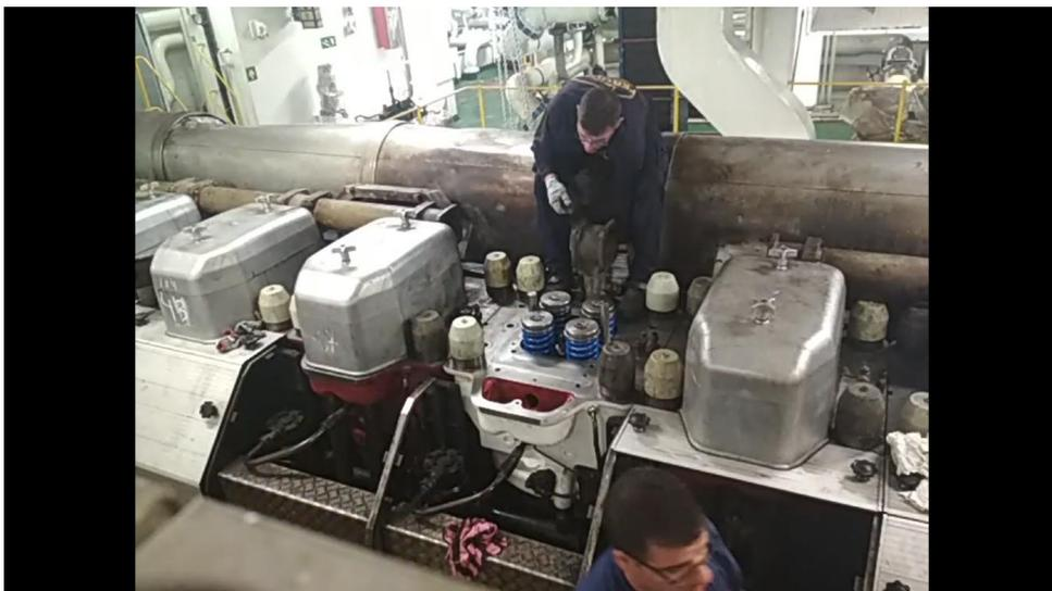
Figura 67. Montaje de tuberías de agua de refrigeración de alta temperatura. Fuente: Trabajo de campo
