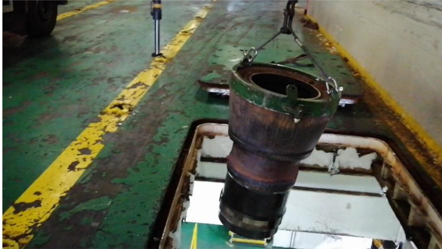
*Figura 54. Retirada de camisa a través de lumbrera. Fuente: Trabajo de campo*
