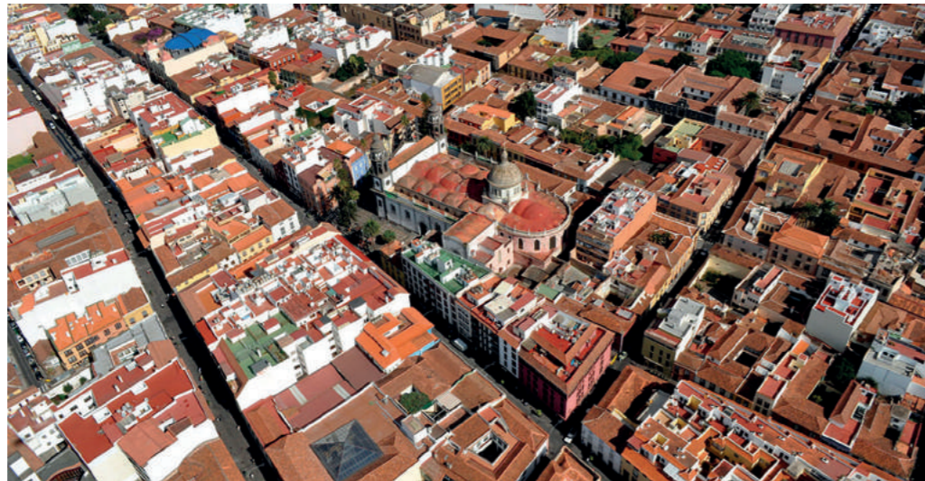
Vista aérea de parte del centro de La Laguna
