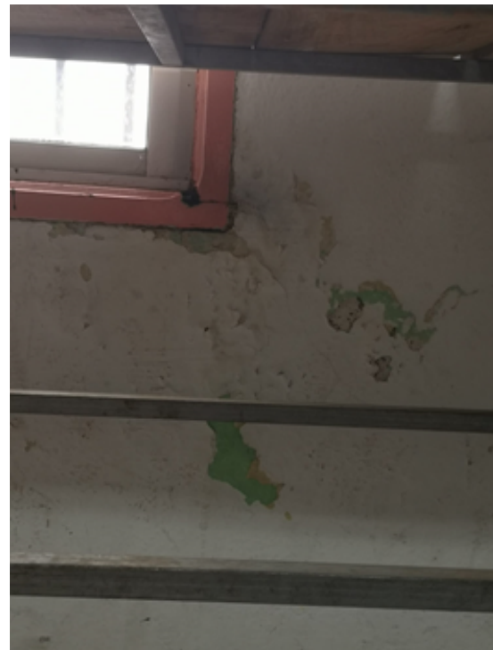
Imagen 3. Desprendimiento de la pintura en la cara interior del muro portante.
