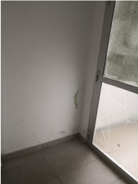
Imagen 2. Desprendimiento de la pintura en la cara interior del muro portante.
