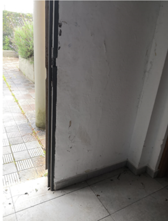
Imagen 4. Humedad por filtración en la cara interior del muro portante.
