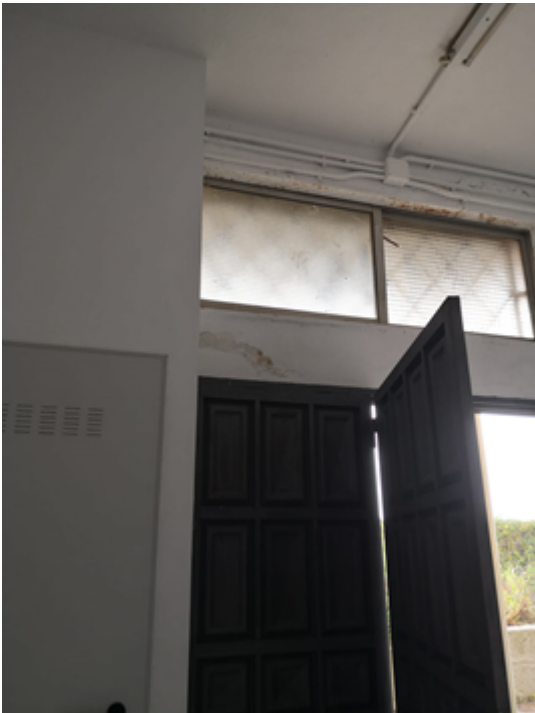
Imagen 1. Desprendimiento de la pintura en la cara interior del muro portante.
