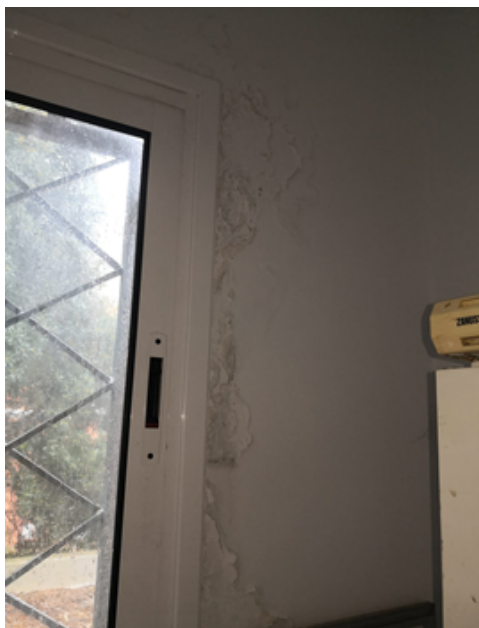
Imagen 4. Humedad por filtración en la cara interior del muro portante.
