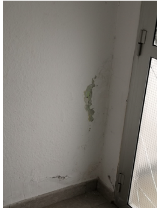
Imagen 2. Desprendimiento de la pintura en la cara interior del muro portante.
