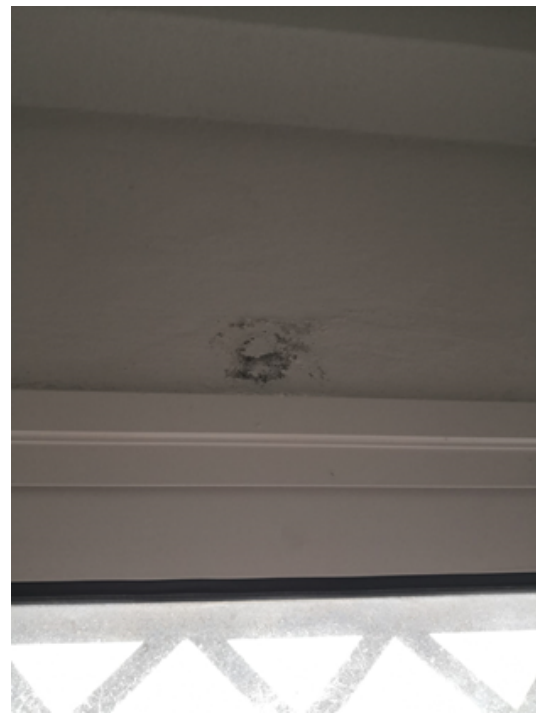
Imagen 6. Humedad por condensación en la cara interior del muro portante.
