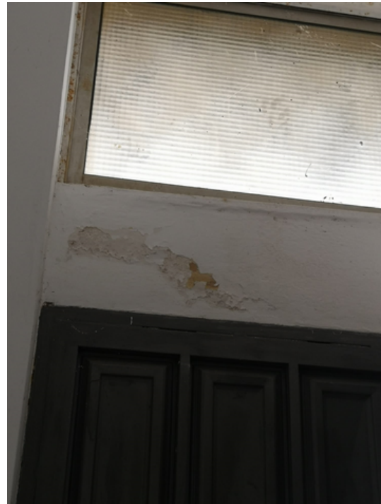
Imagen 1. Desprendimiento de la pintura en la cara interior del muro portante.
