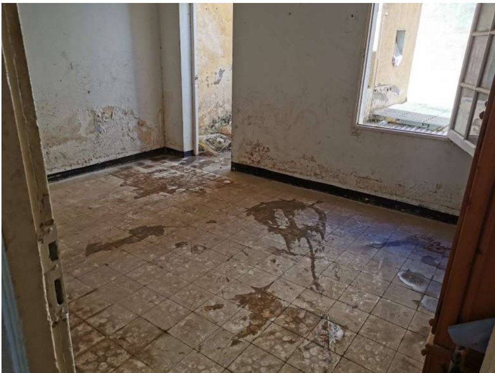
Zona de ensayo Prueba N° 02
