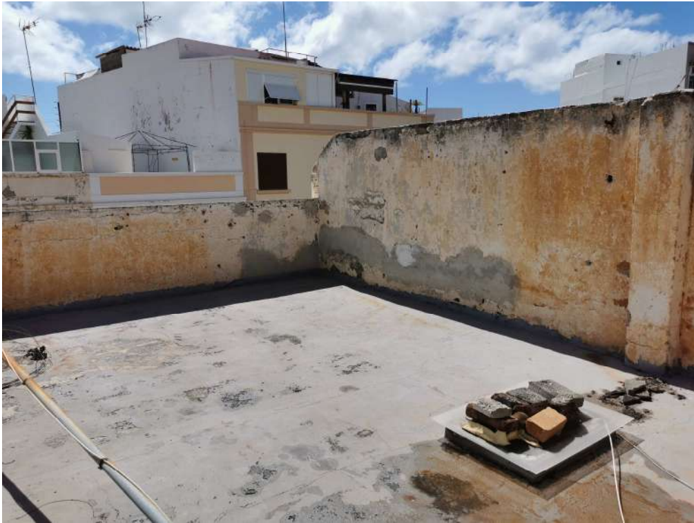
Zona de ensayo Prueba N° 01
