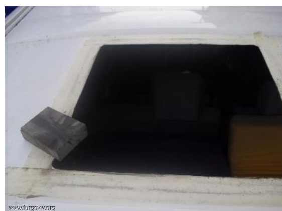
Ilustración 24 Instalación de claraboya
