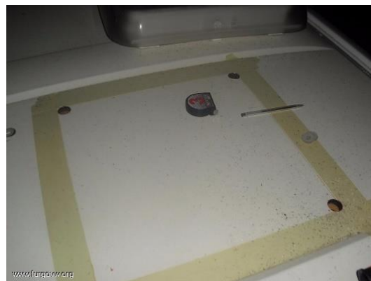
Ilustración 22 Instalación de claraboya
