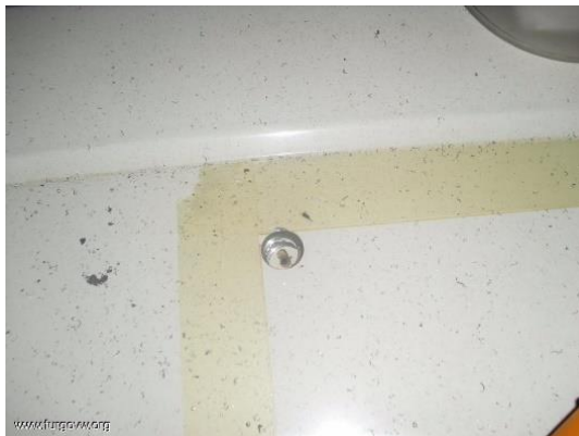
Ilustración 23 Instalación de claraboya
