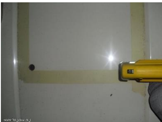
Ilustración 25 Instalación de claraboya
