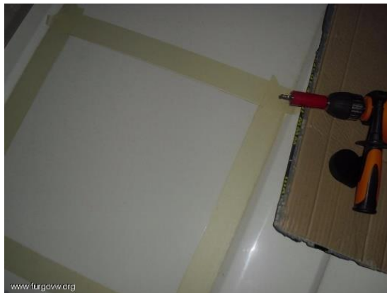
Ilustración 20 Instalación de claraboya
