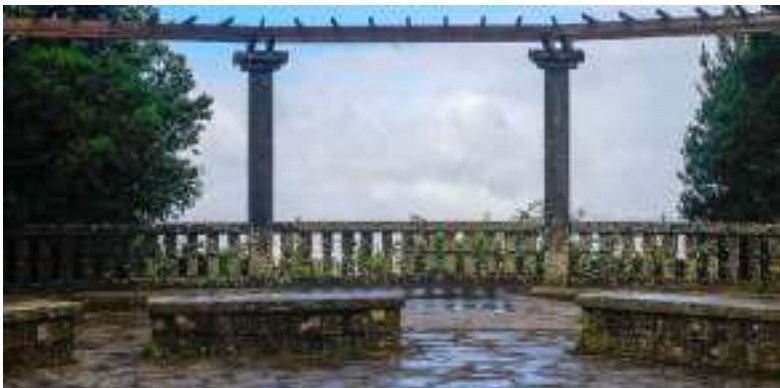
Estructura del mirador.
