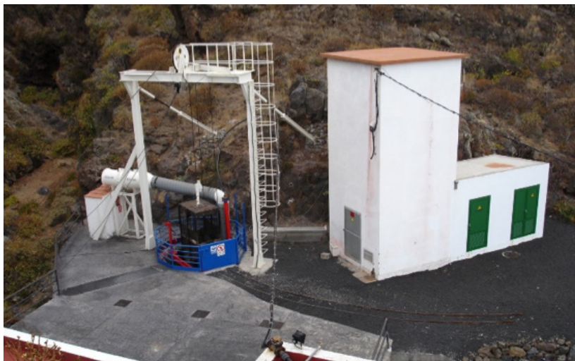
Figura 3.3. Instalaciones del pozo Tamaduste
