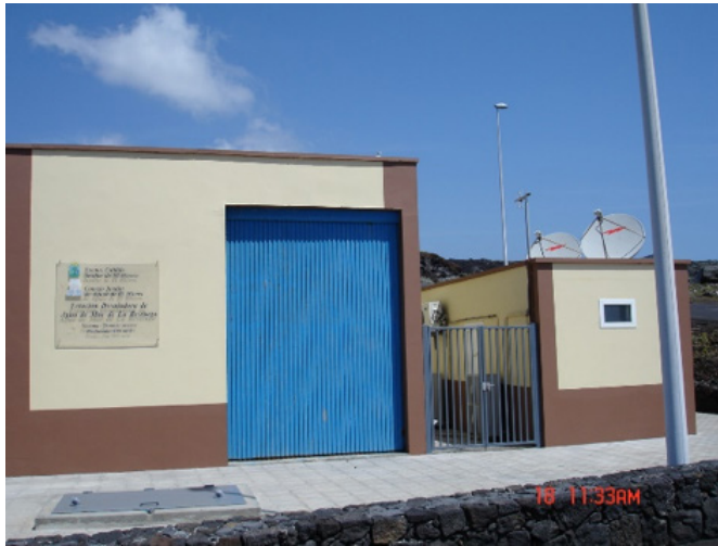
Figura 5.2. Instalaciones desaladora La Restinga
