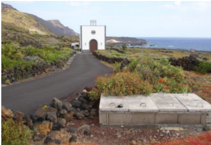
Figura 5.1. Instalaciones desaladora El Cangrejo
