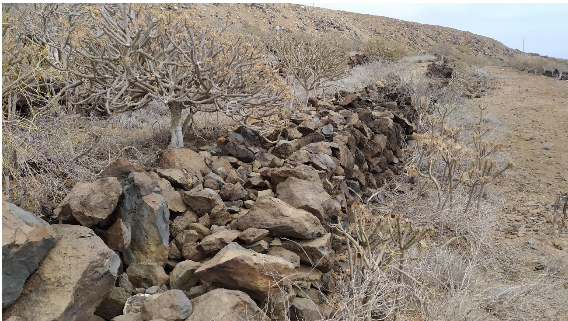
Figura Nº2.4: Imagen del estado actual de los muros de piedra seca.
